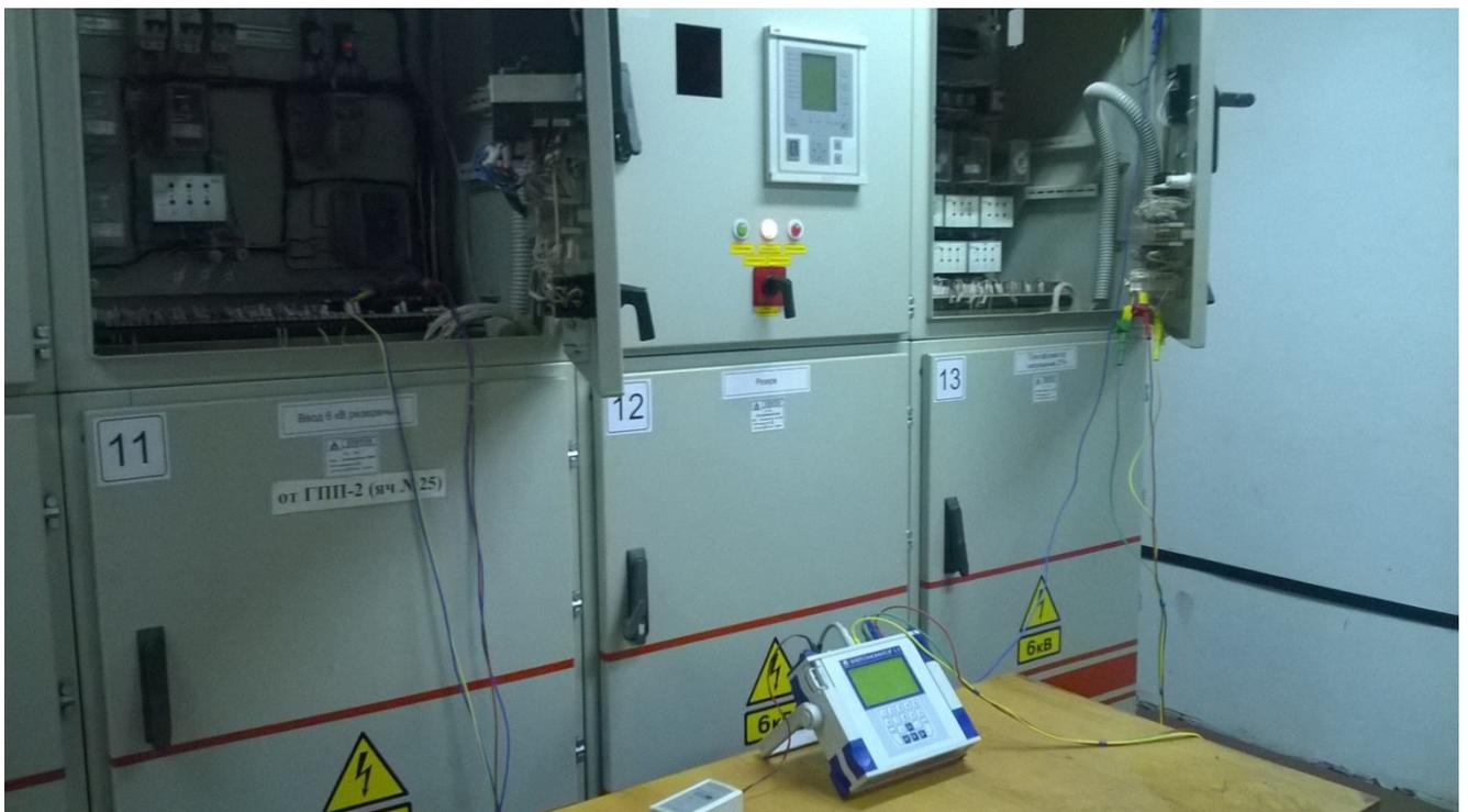
Рисунок 2. Регистрация электрических параметров прибором «Энергомонитор - 3.3Т1»
