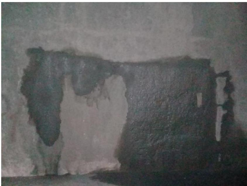
Рисунок 3.10 - Инфильтрация воды через горизонтальные рабочие швы тоннеля «Истиклол»
