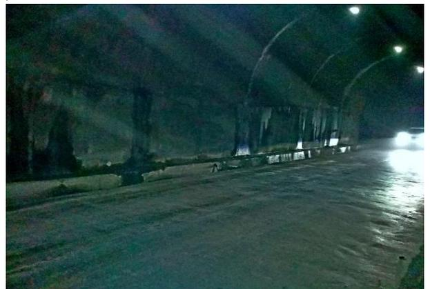
Рисунок 2.11 - Инфильтрация воды через холодные швы тоннеля «Истиклол» 2017 г.
