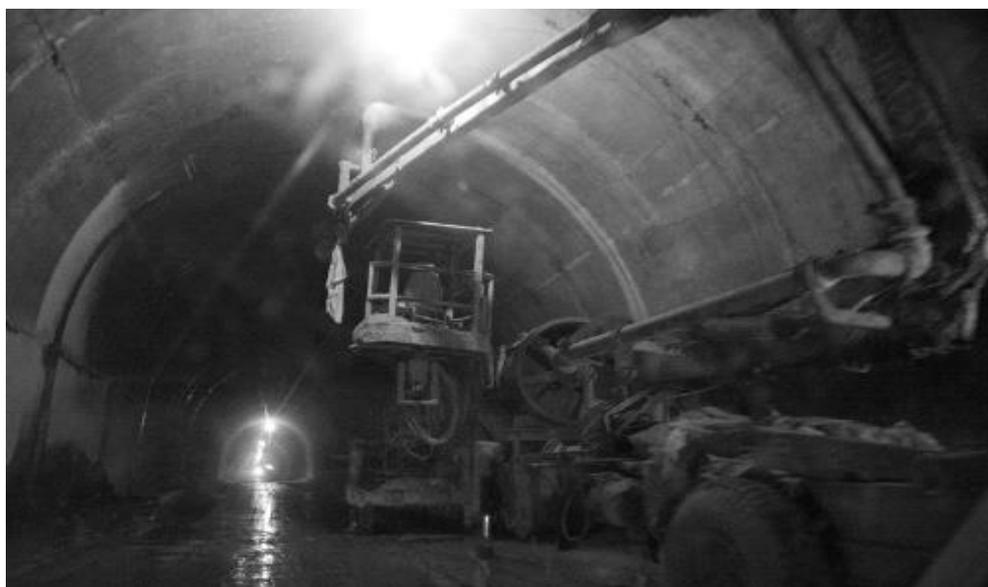
Рисунок 3.9 - Гидроизоляционные работы в тоннеле «Истиклол»
