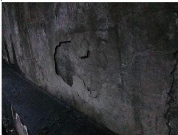
Рисунок 2.4 - Расслаивание защитного слоя поверхности крепи тоннеля «Истиклол»
