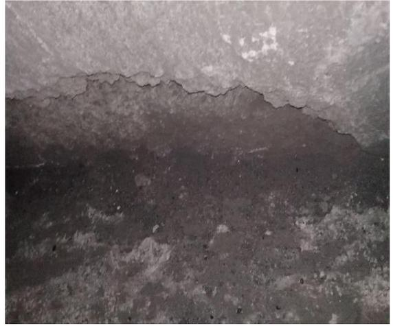
Рисунок 2.1 - Раковины в обделке тоннеля «Истиклол»
