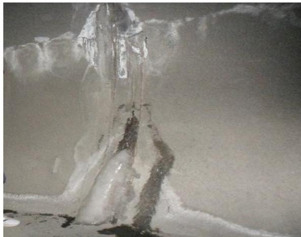
Рисунок 2.6 - Последствие влияния инфильтрационных вод в тоннеле «Шахристан»
