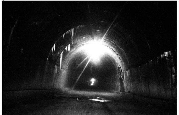
Рисунок 1.4 - Автодорожные тоннели «Истиклол» и «Шахристан». а- инфильтрационные подземные воды в тоннеле «Шахристан»; б - сосульки на стенах тоннеля «Истиклол»
