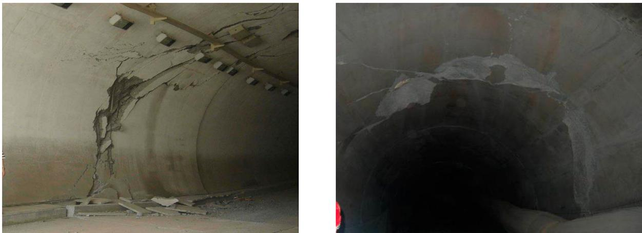
Рисунок 1.5 - Разрушение тоннелей при землетрясении 2008 года в Вэньчуань (Китай)
