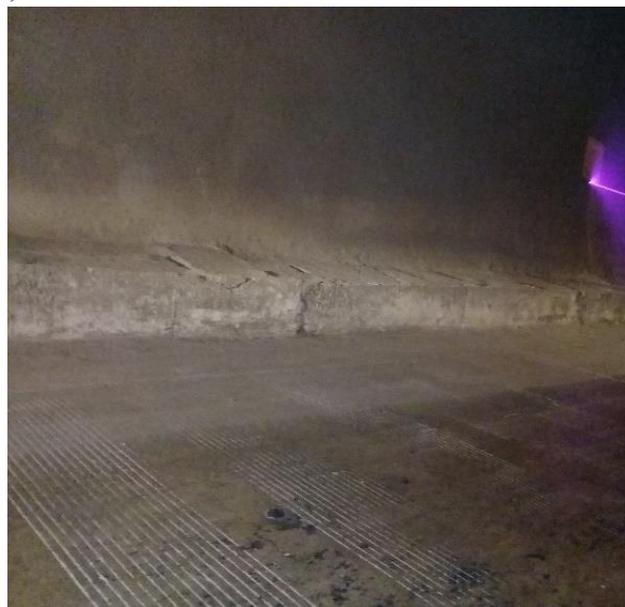
Рисунок 2.17 – Сейсмическое воздействие в автодорожном тоннеле «Шахристан»: а- разрушение лотковой части; б - волнообразные деформации
