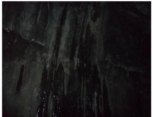
Рисунок 2.14 - Наледообразование и сосульки в середине тоннеля «Истиклол»
