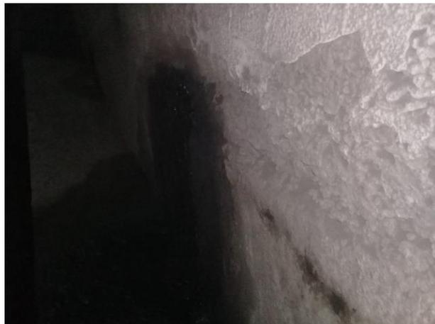
Рисунок 2.5 - Выщелачивание обделки тоннеля «Истиклол»
