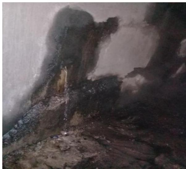
Рисунок.3.11 - Инфильтрация воды через трещины обделки тоннеля «Истиклол»
