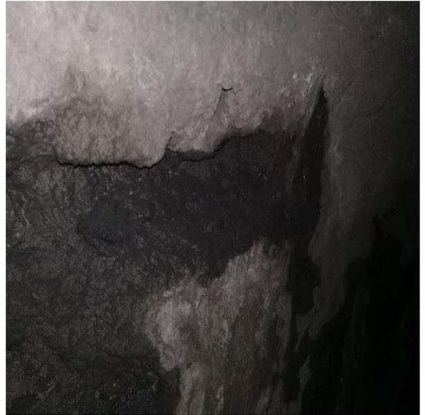
Рисунок 2.16 - Разрушение стен тоннеля «Истиклол»
