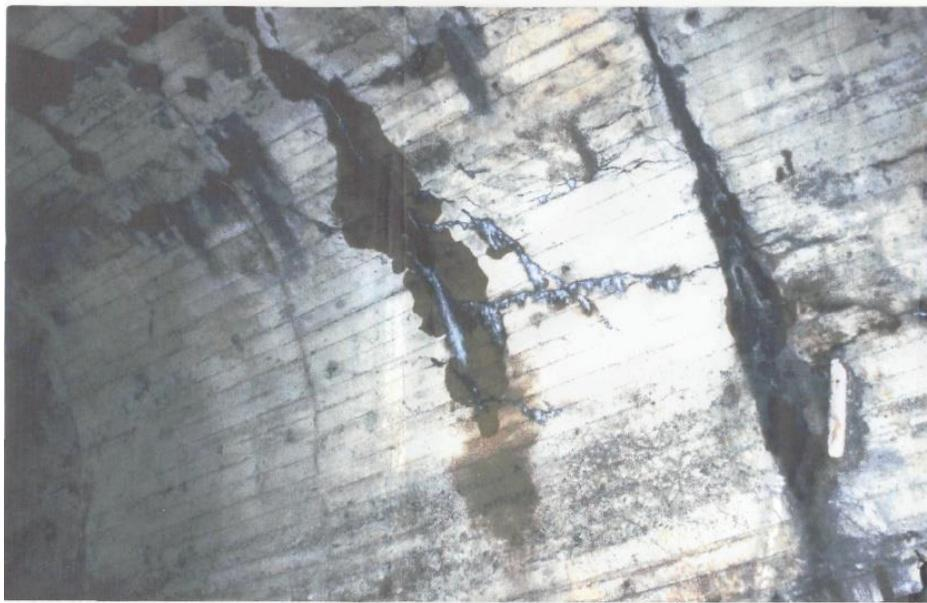
Рисунок 1.7 - Образование морозобойных трещин в Манском тоннеле
