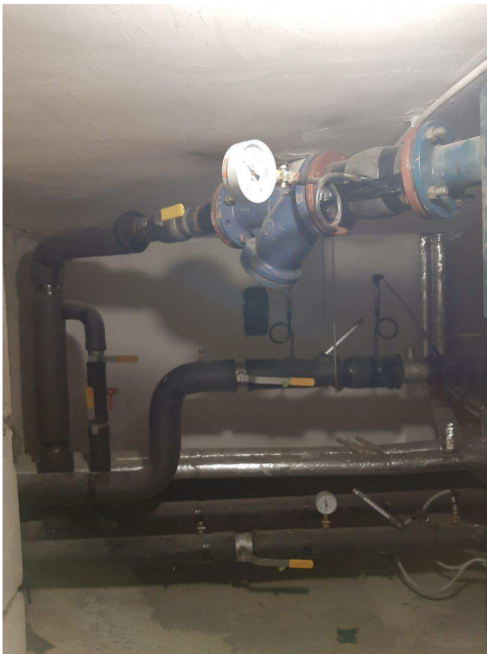
Рисунок 2 – Трубопровод ввода теплосети в жилое здание
