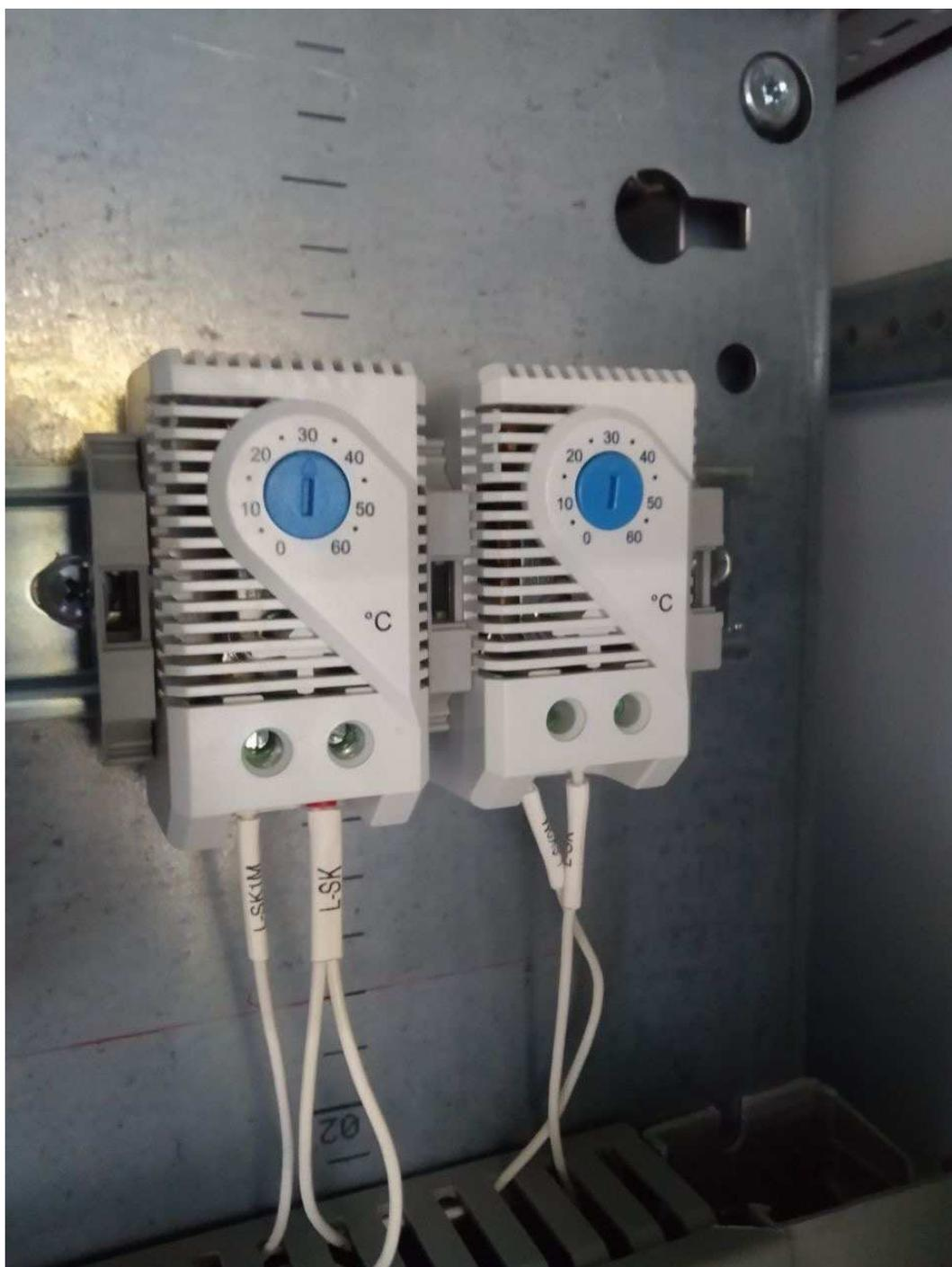
Рисунок 7 – Термостаты внутри шкафа
