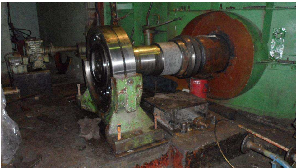
Рисунок 19 – Восстановленный вал на месте установки вентилятора
