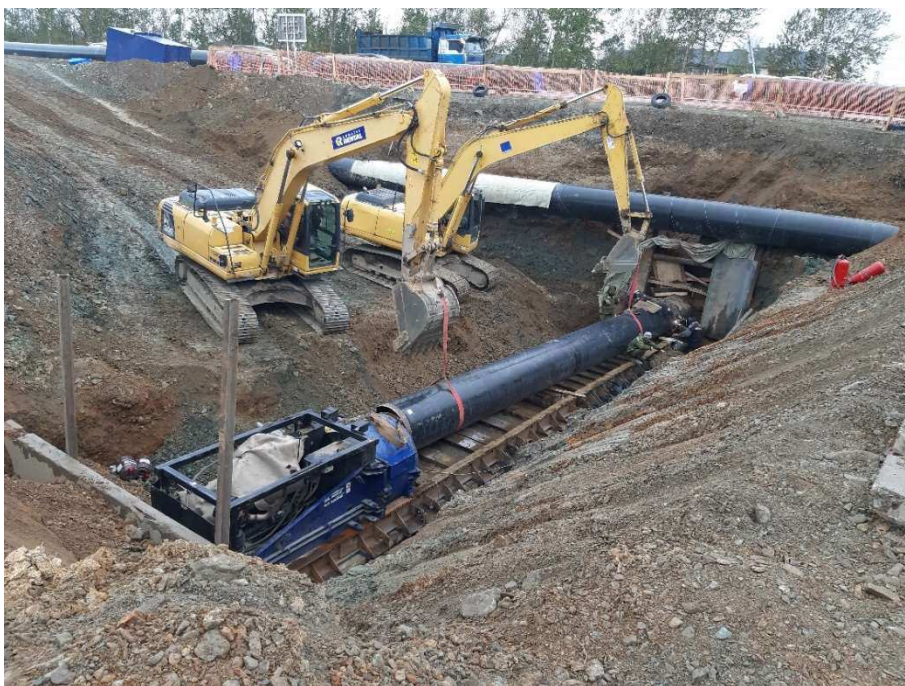
Фотография8. Стартовый котлован по технологии микротоннелирования.
