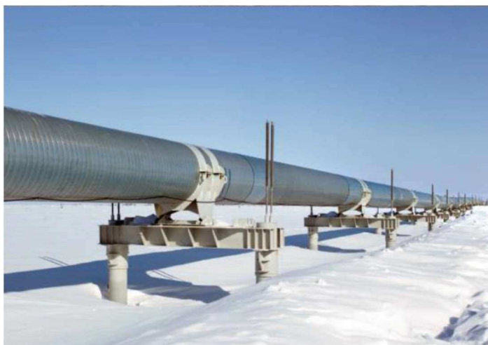
Фотография 6. – Продольно-подвижная и свободно-подвижная опора
