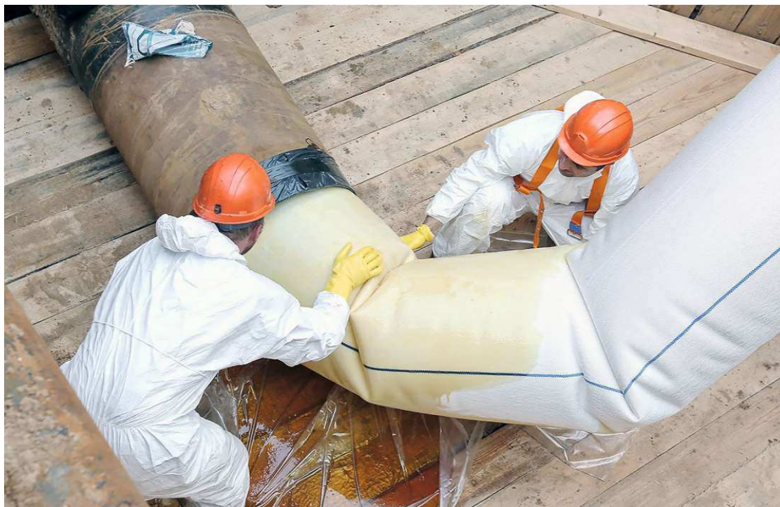
Фото 10. Подача полимерного чулка в трубопровод
