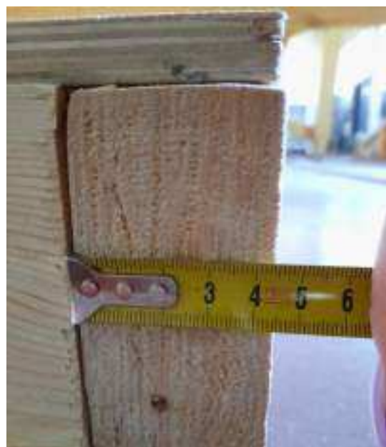
Рисунок 10.6 – Измерение толщины ребер плиты (толщина продольного ребра 45 мм)
