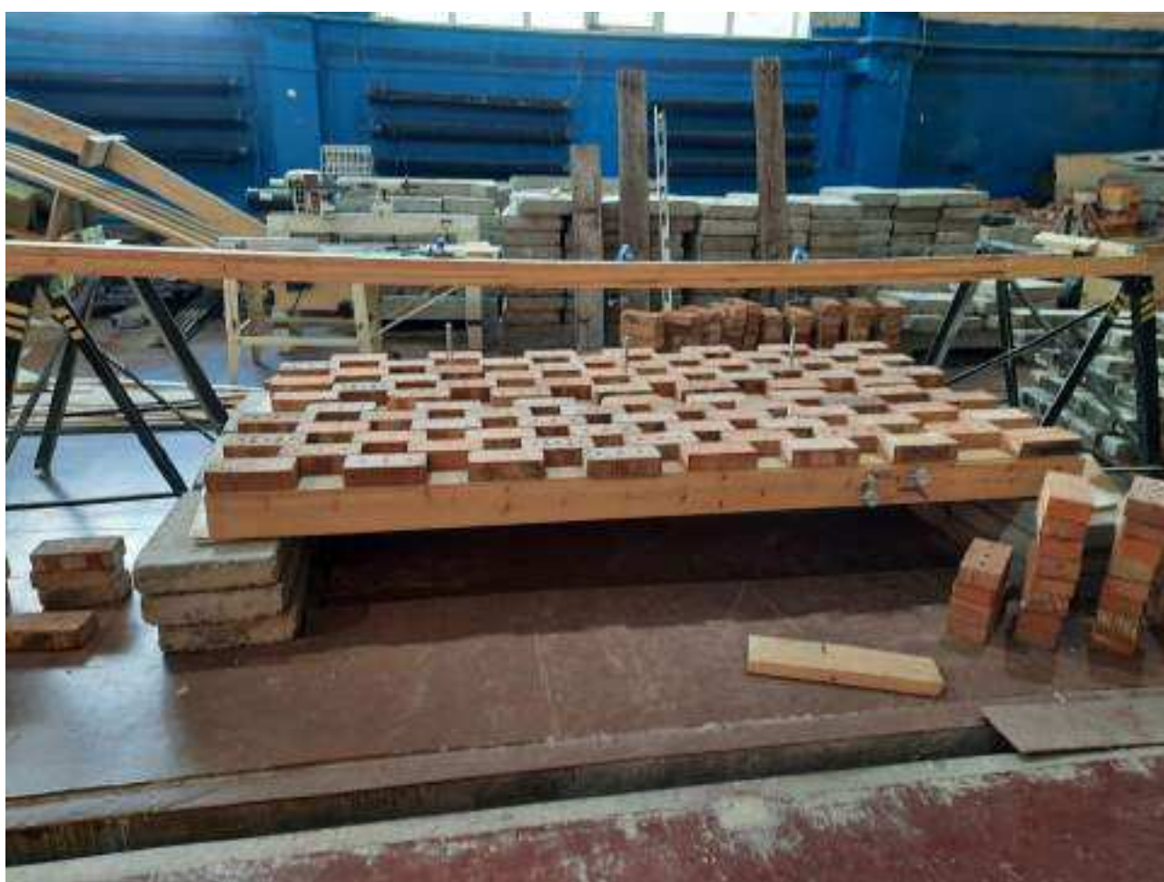
Рисунок 10.29 – Нагружение конструкции. Ступень 1. Вид 1
