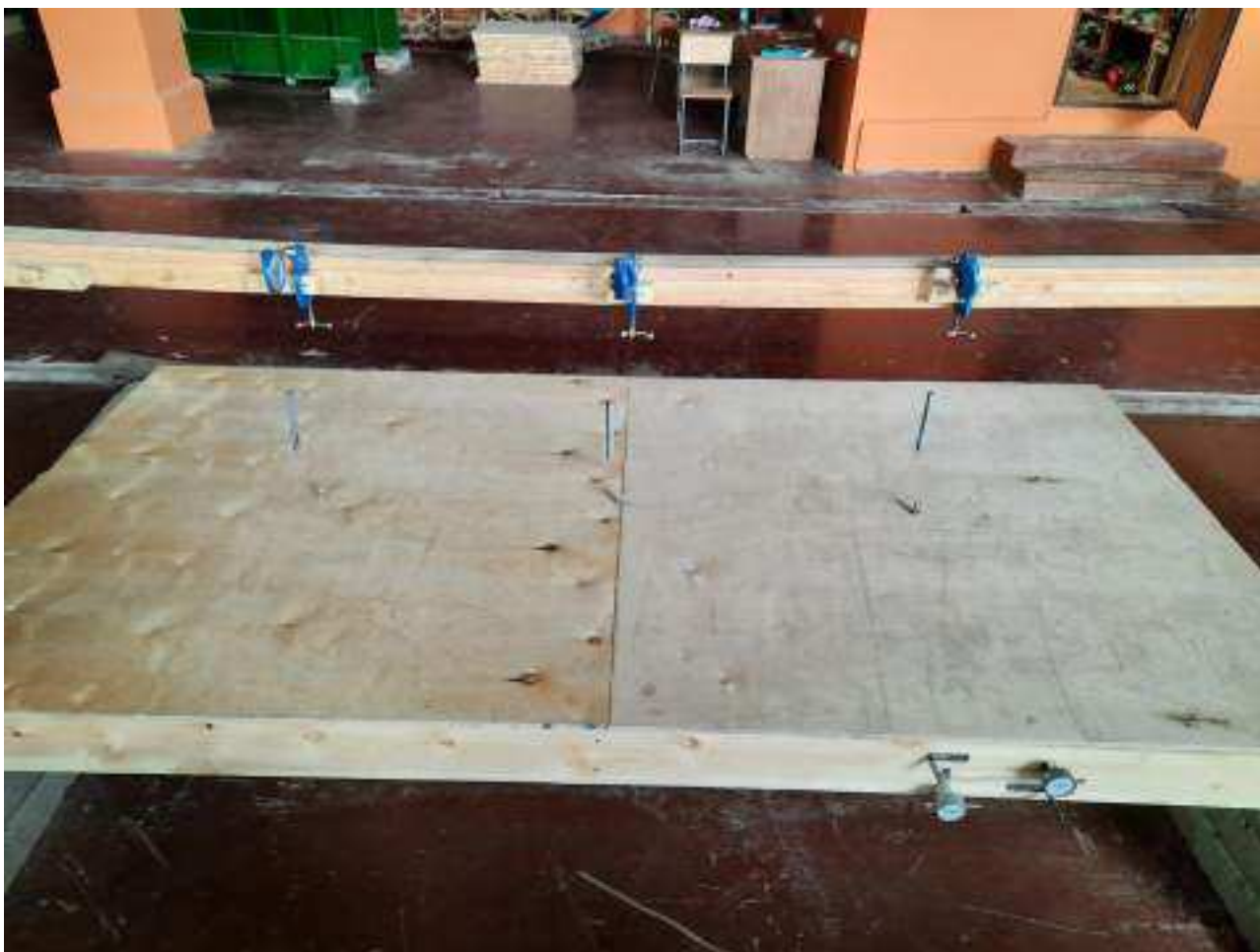
Рисунок 10.15 – Установленные прогибомеры Аистова. Вид 2
