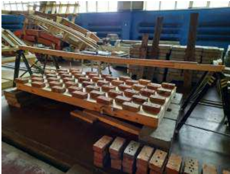
Рисунок 10.19 – Нагружение конструкции. Ступень 1. Вид 2
