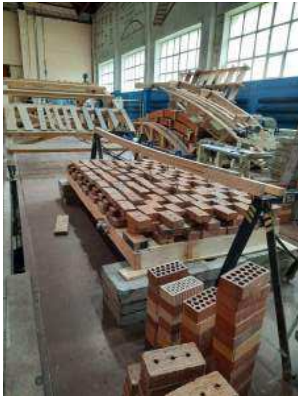
Рисунок 10.33 – Нагружение конструкции. Ступень 3. Вид 1
