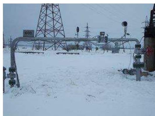
Рисунок 5 – Нагнетательная скважина в НГДУ «Прикамнефть»
