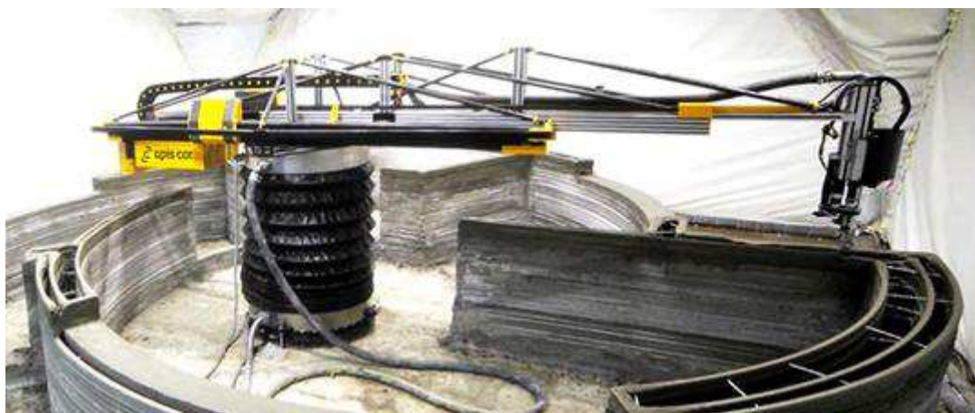
Рисунок 4 – Строительный 3D принтер манипуляторного типа компании Apri cor.
