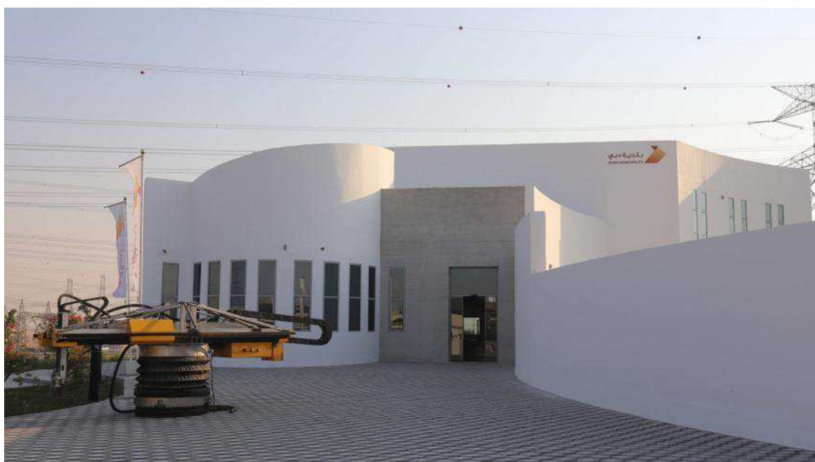
Рисунок 2 – Результат строительной 3D печати в ОАЭ
