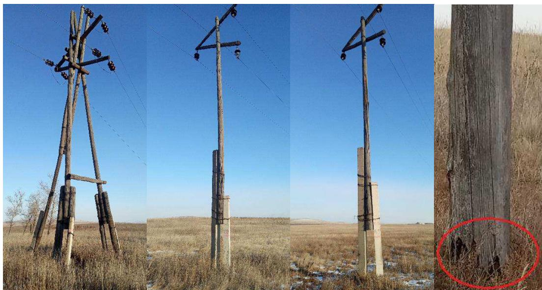
Рисунок 2 – Состояние деревянных опор
