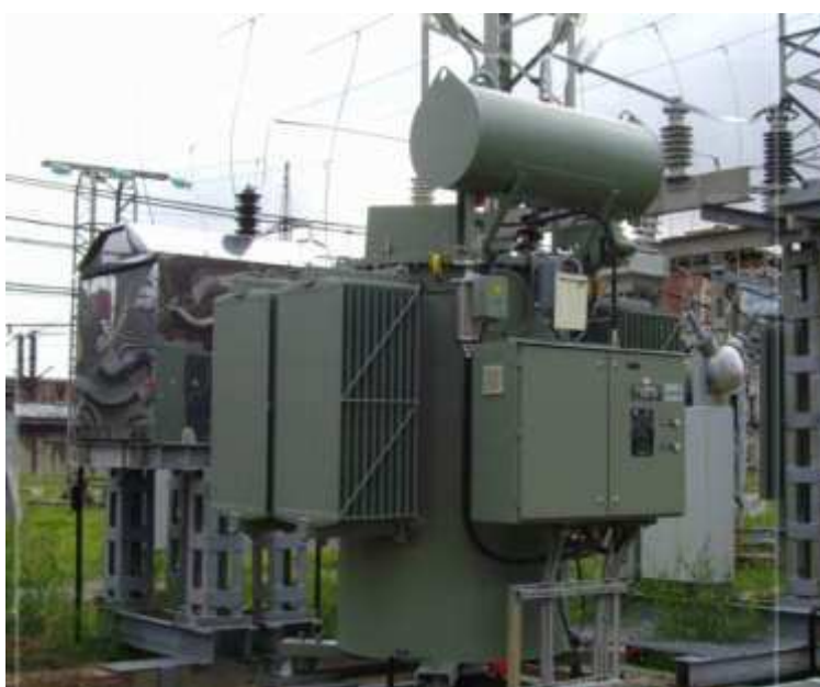
Рисунок 3 – Дугогасящий реактор
