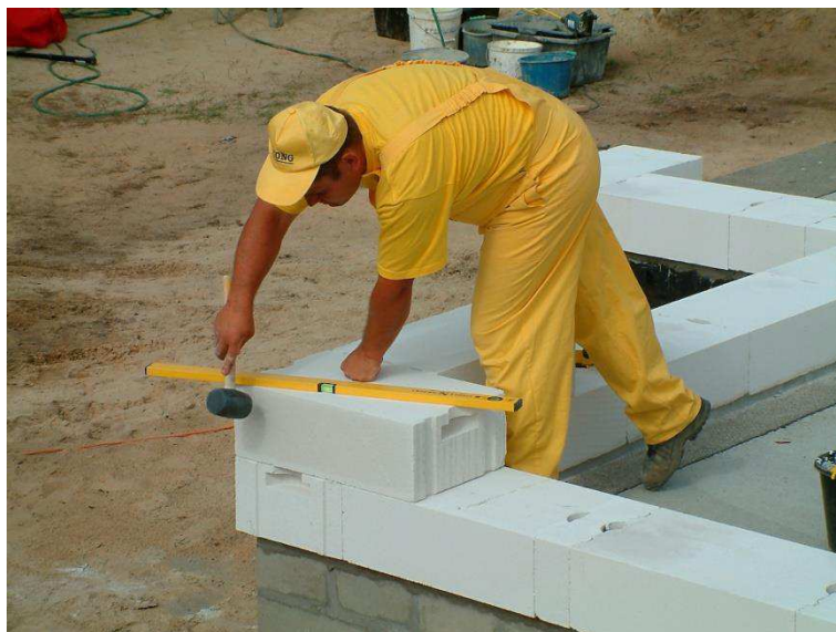
Рис. Кладка из газобетонных блоков
