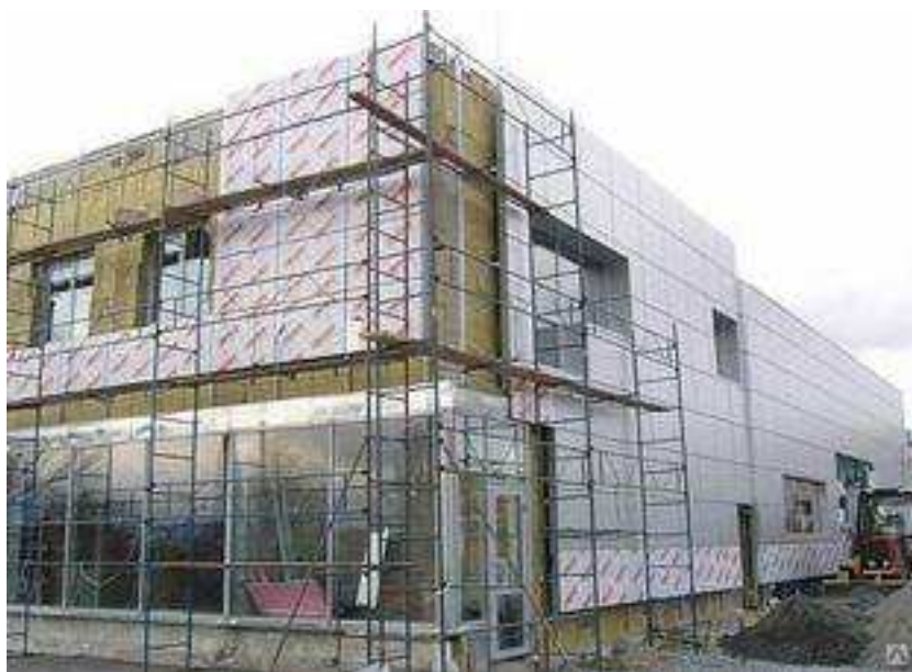
Рис. Фрагмент фасада строящегося здания
