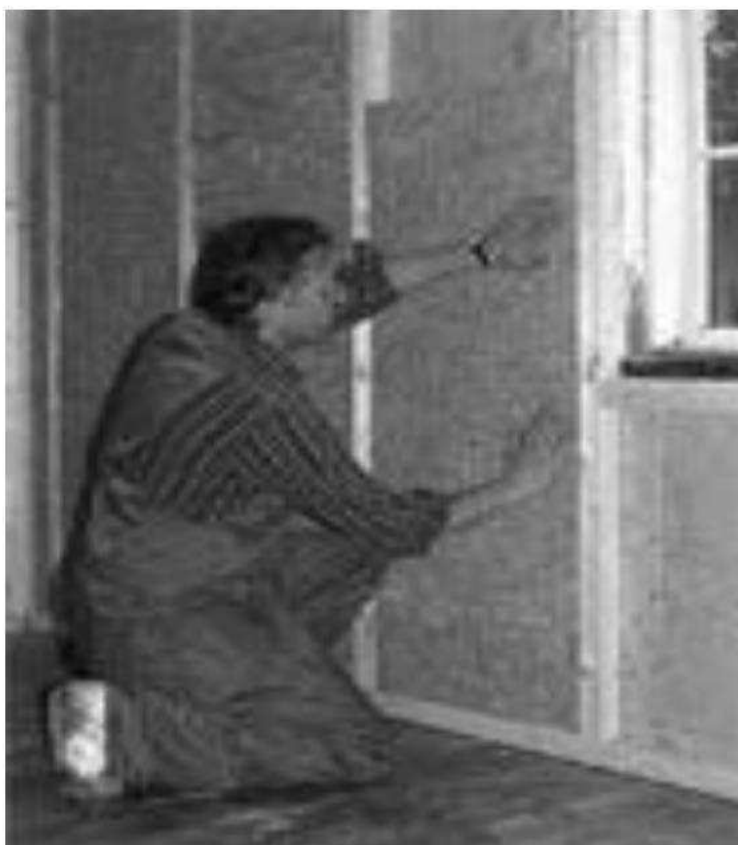
Рис. Утепление помещения изнутри мягкими плитами PAROK
