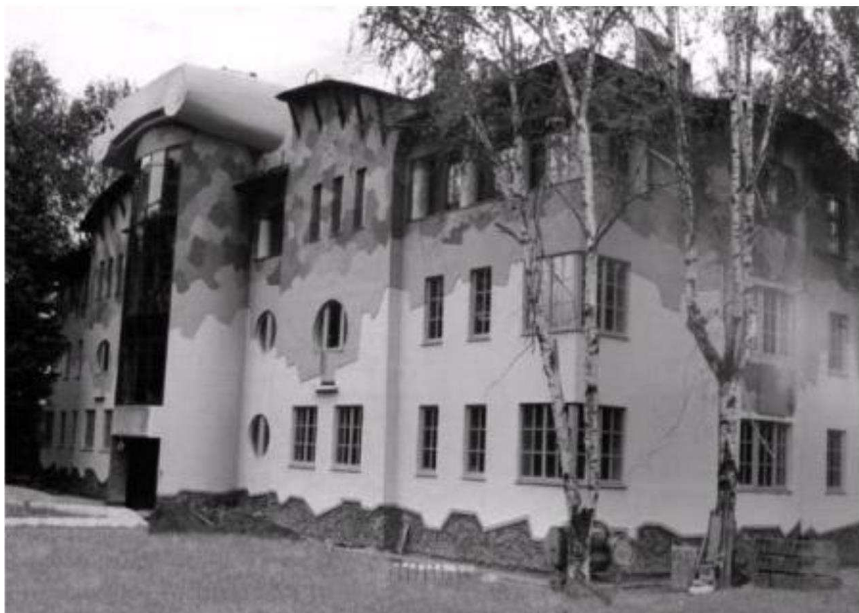
Рис. Фасад здания с тонкослойной системой наружного утепления
