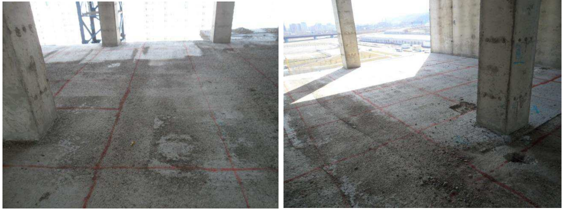
Рисунок 3.6 - Монолитная плита перекрытия сверху до нагружения
