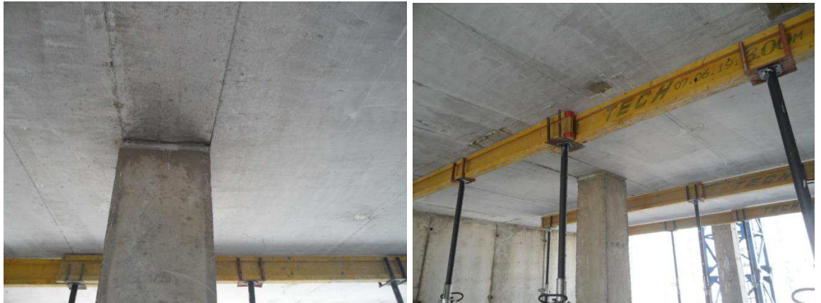
Рисунок 3.7 - Монолитная плита перекрытия снизу до нагружения
