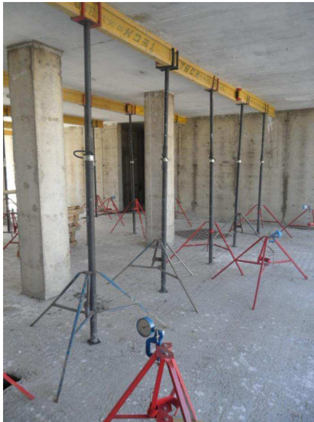
Рисунок 3.8 - Установка прогибомеров БПАО
