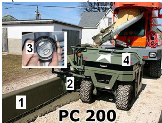
Рисунок 1. Процесс контроля растекаемости монолитного бруса из свежего бетона:
