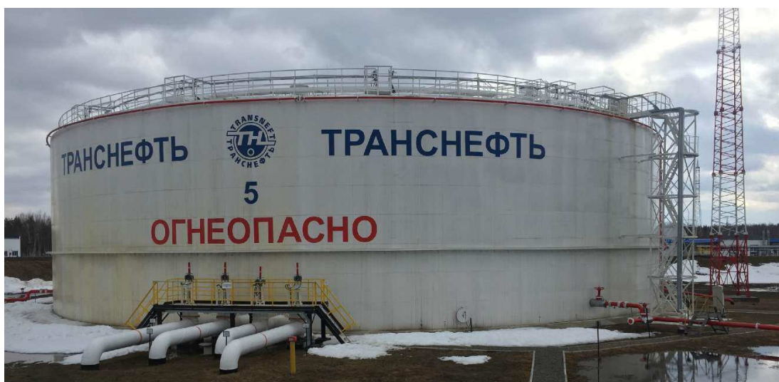
Рисунок 3 – Вертикальный цилиндрический резервуар с щитовой кровлей
