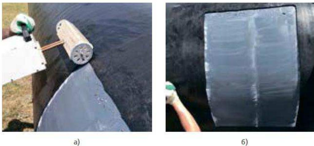
Рисунок 3.7 – Технология очистки труб: а – прогрев полос покрытия ручным микроволновым генератором; б – ручное снятие прогретого покрытия
