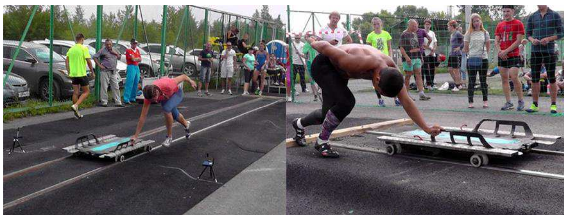
Рисунок 11 – Рельсовая эстакада с тренажером скелетон, г. Красноярск
