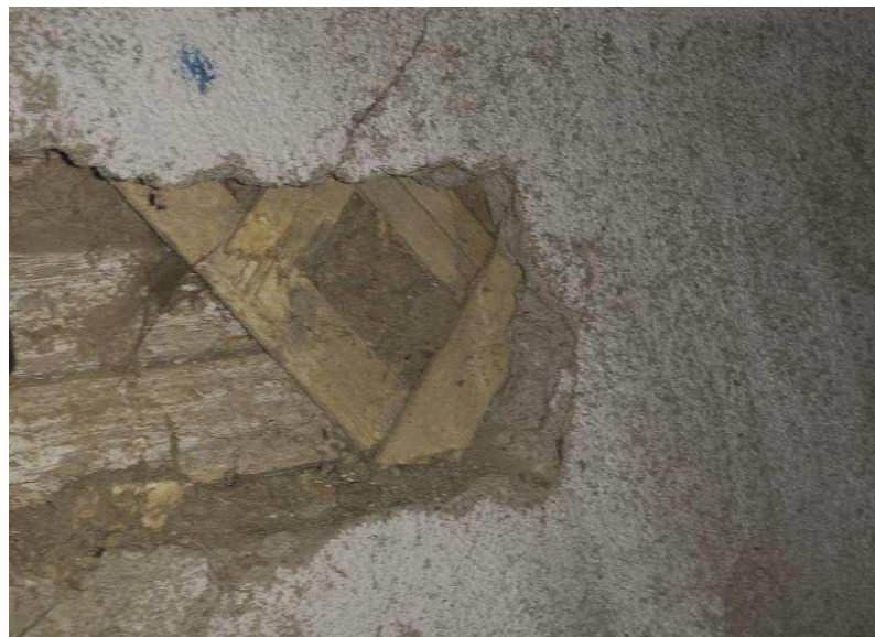
Рисунок 2.4 - Результаты вскрытия наружных стен изнутри
