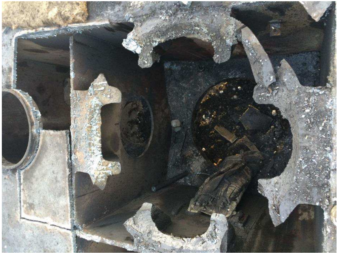
Рисунок 3.1 - Общий вид разрушенной базы
