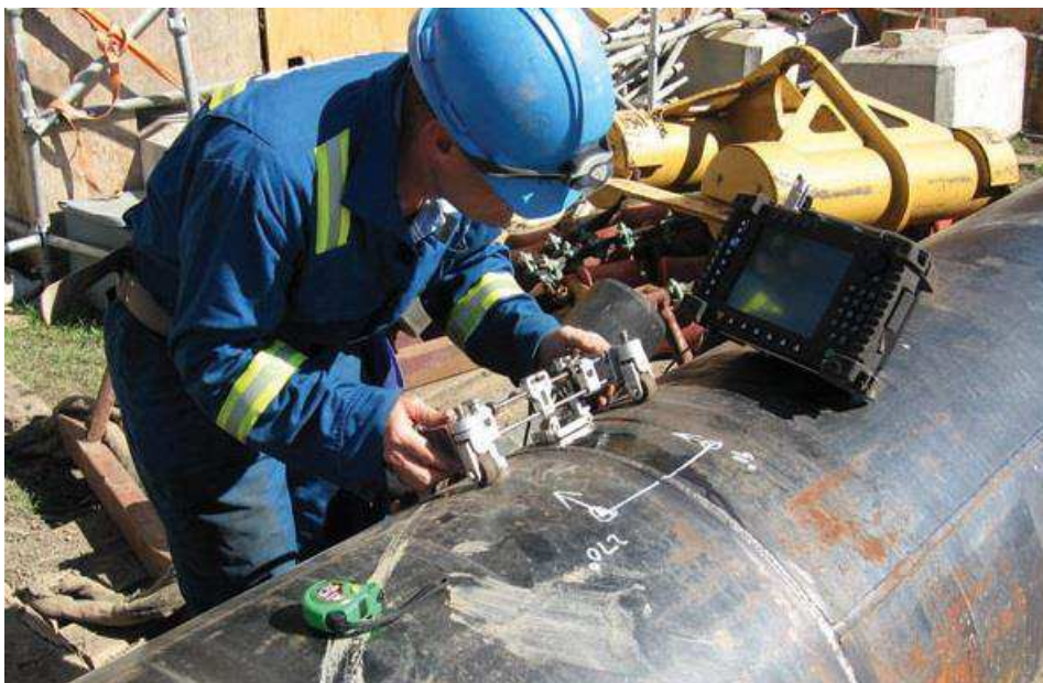
Рисунок 10 – Проведение УЗК кольцевого сварного шва
