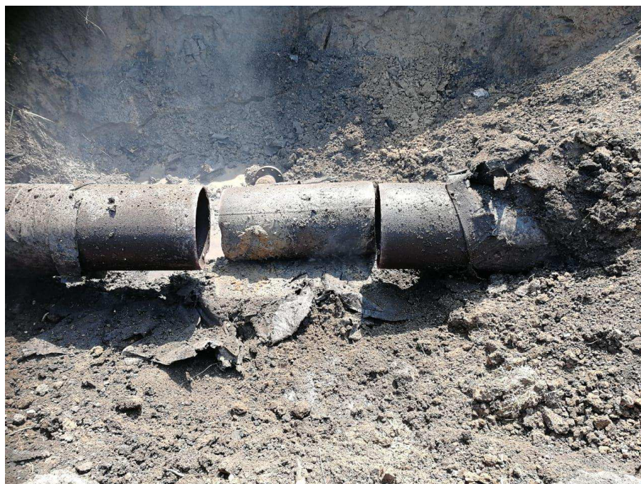
Рисунок 8 – Вырезка трубопровода методом взрыва
