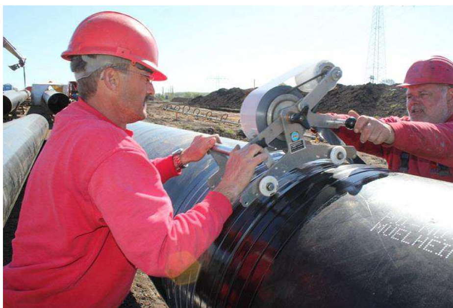
Рисунок 11 – Нанесение ленточного изоляционного покрытия
