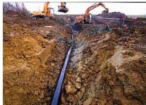
Рисунок 13 – Укладка в траншею
