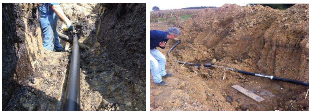
Рисунок 14 – Санация методом «труба в трубе без разрушения» (протягивание ПАТ в повреждённом трубопроводе)
