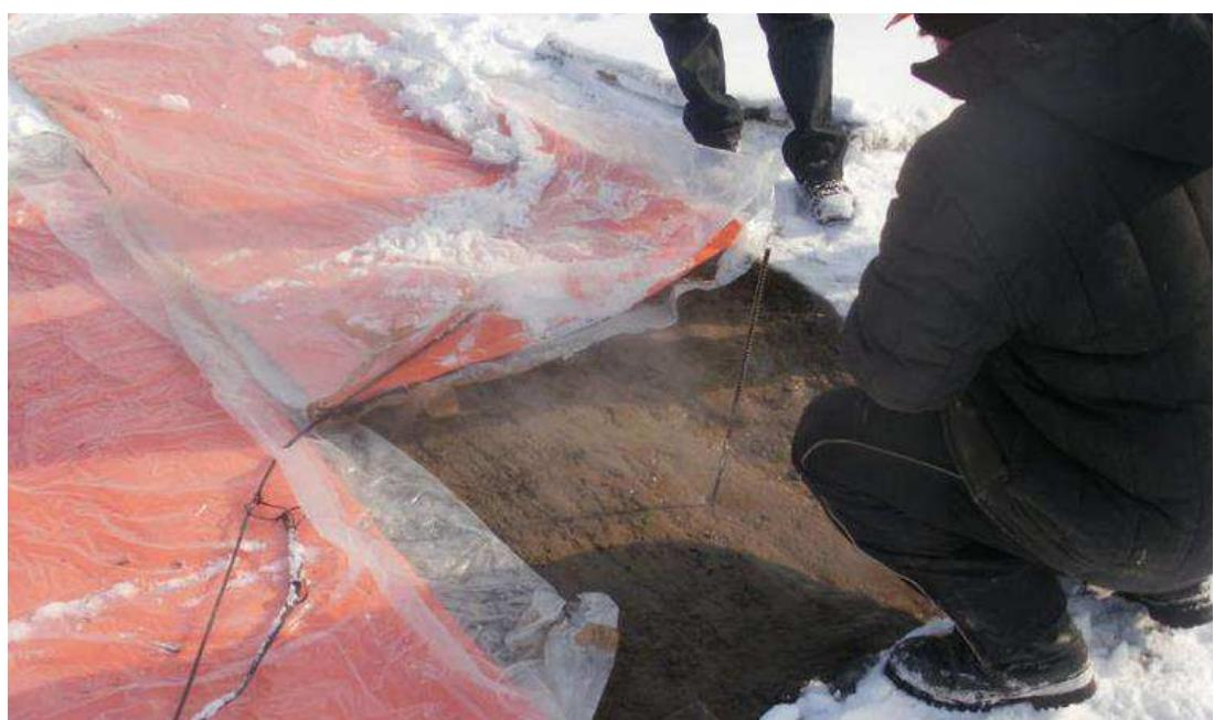
Рисунок 2.6 – Термоматы для прогрева грунта
