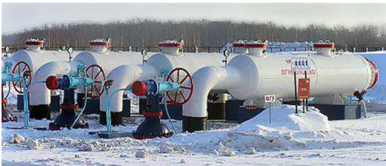
Рисунок 5 – Горизонтальные фильтры-грязеуловители
