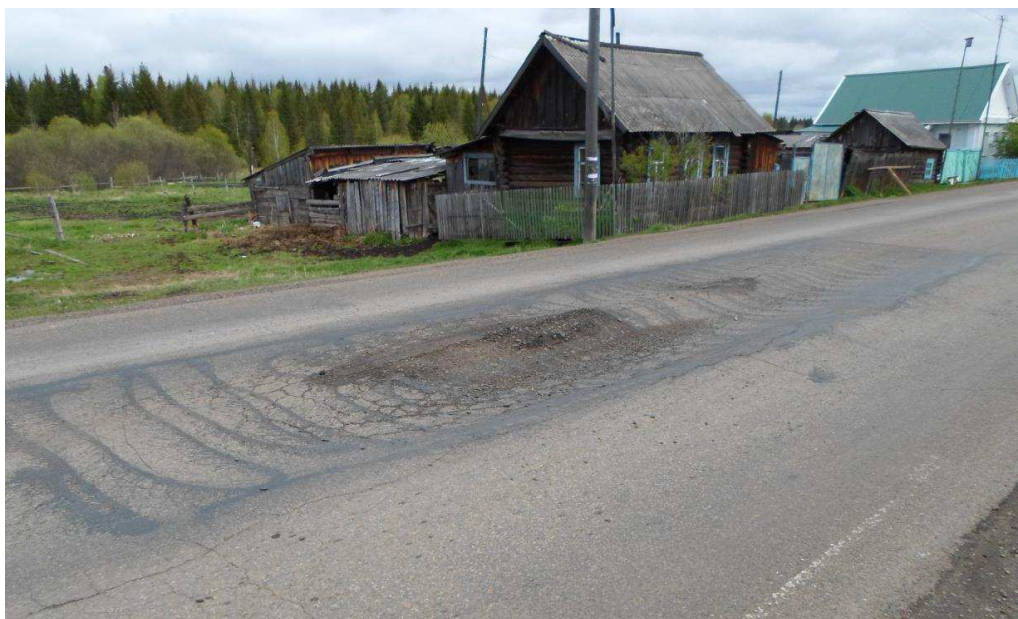
Рисунок 14 – а/д «Пировское – Комаровка» - Просадка слабого основания с продавливанием грунта от воздействия транспорта
