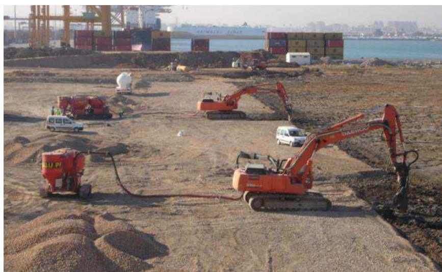
Рисунок 12 – смешивание при стабилизации массивом
