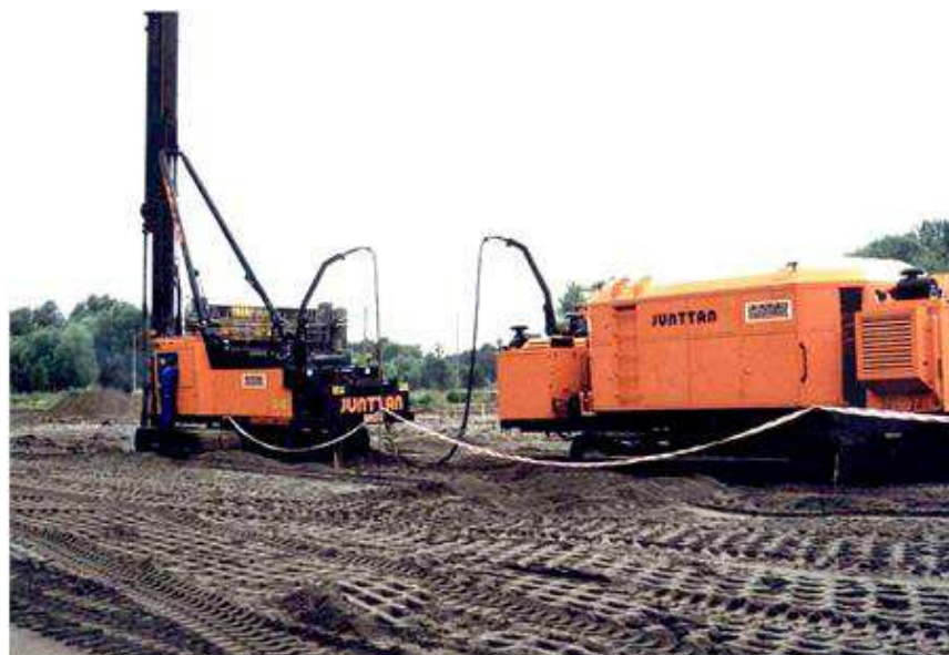
Рисунок 11 – смешивание при стабилизации колоннами
