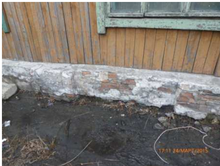
Рисунок 4.3.2 – Фундамент и отмостка здания
