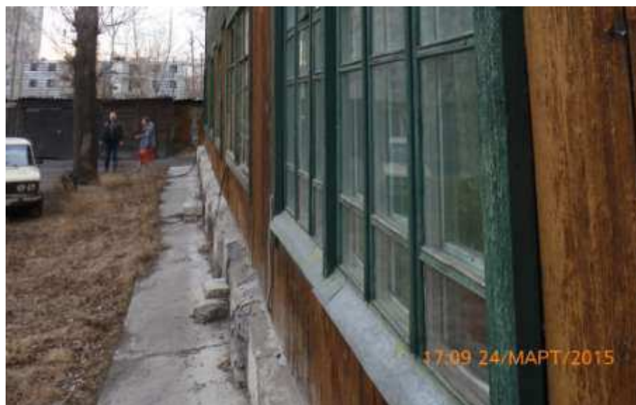
Фото 4.3.1 – Фундамент и отмостка здания
