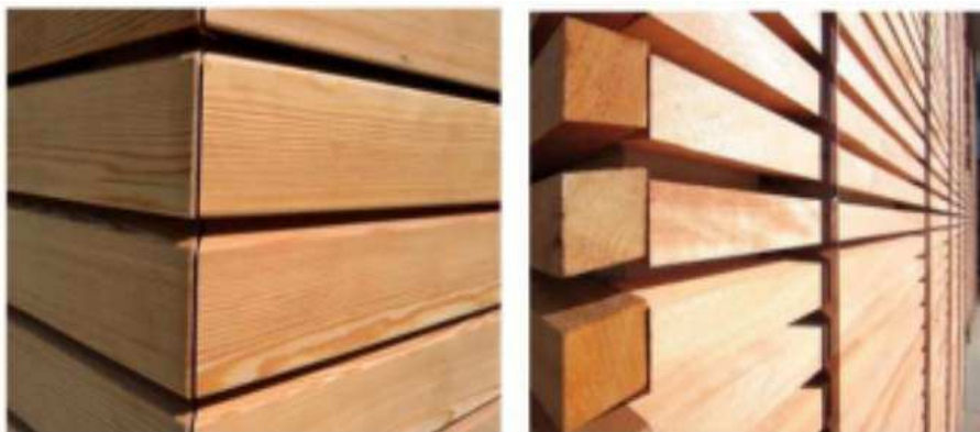
Рисунок 2.1 – Фасад исследуемого здания
