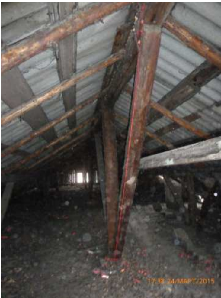
Рисунок 4.3.3 – Стропильная система крыши здания.
