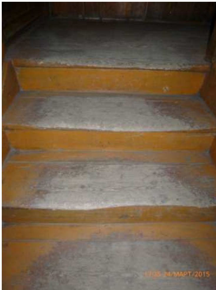
Рисунок 4.3.4 – Лестница внутри здания.
