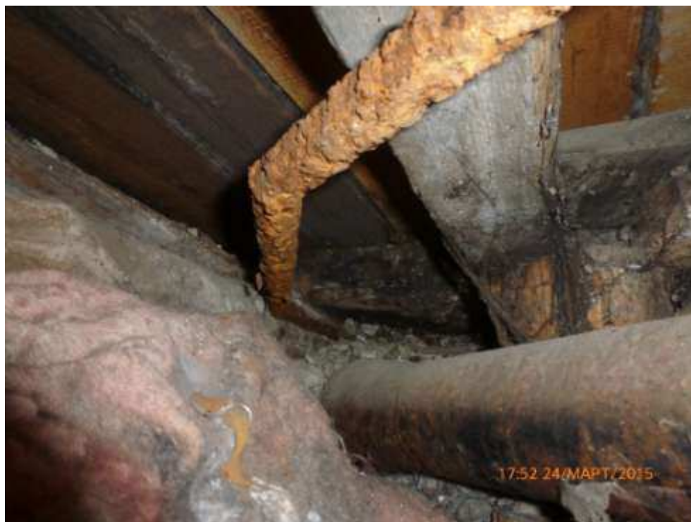
Рисунок 4.3.5 – Инженерные системы внутри здания.
