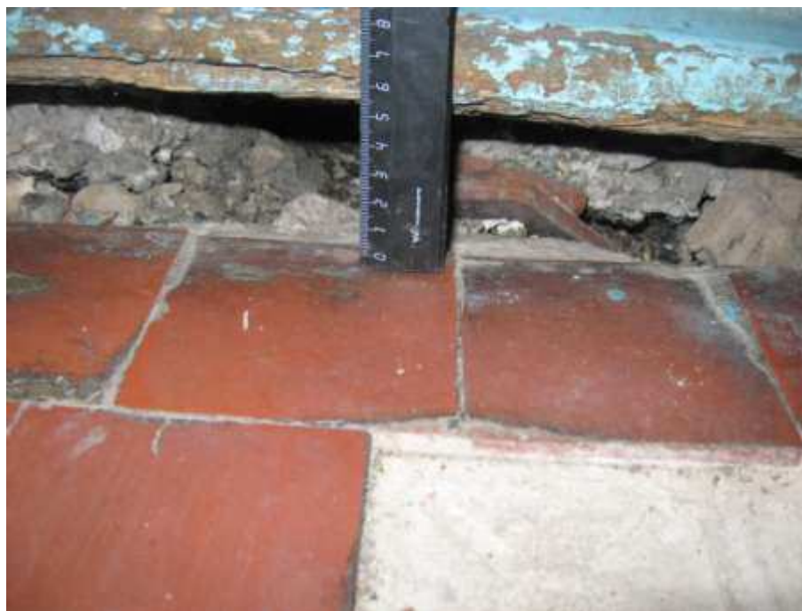
Рисунок 6.11 - Провалы уровня пола здания Мировых судей
