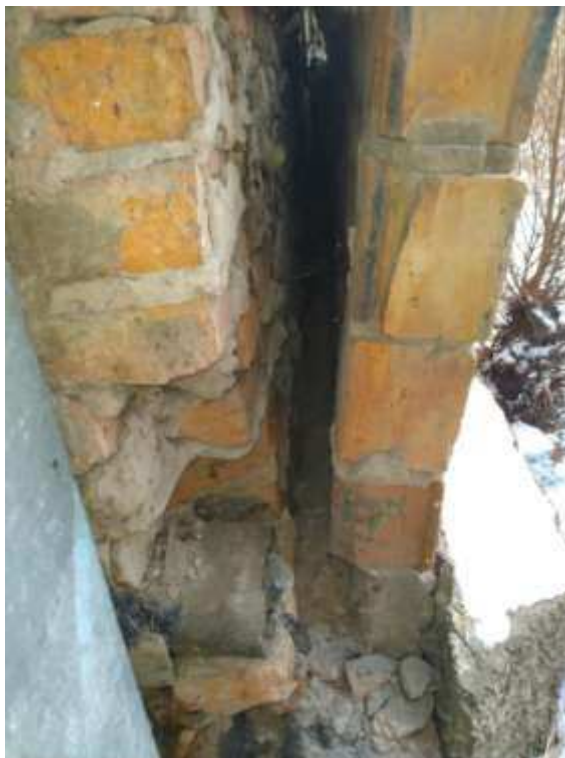
Рисунок 6.7 - Отслоение облицовочной версты из двойного кирпича стены здания Мирowych судей
