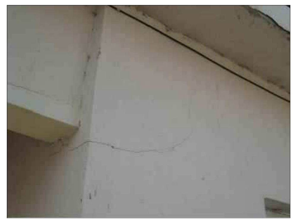
Косые трещины в углу обследуемого здания шириной до 3 мм
