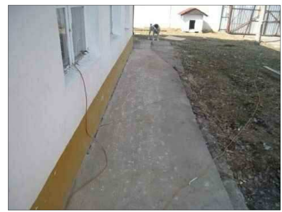
Трещин и других признаков осадочных деформаций в конструкциях фундамента здания не зафиксировано
