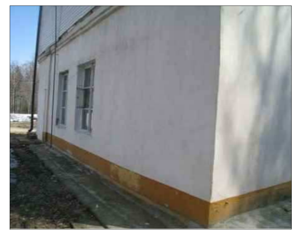
Косые трещины в углу обследуемого здания шириной до 3 мм
