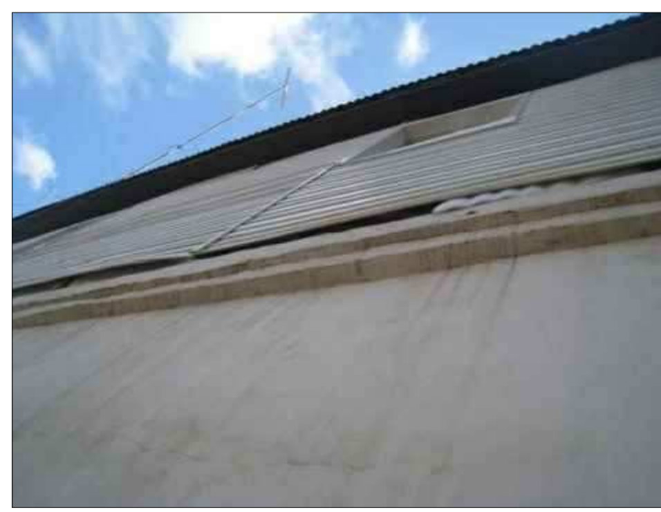
Косые трещины в углу обследуемого здания шириной до 3 мм
