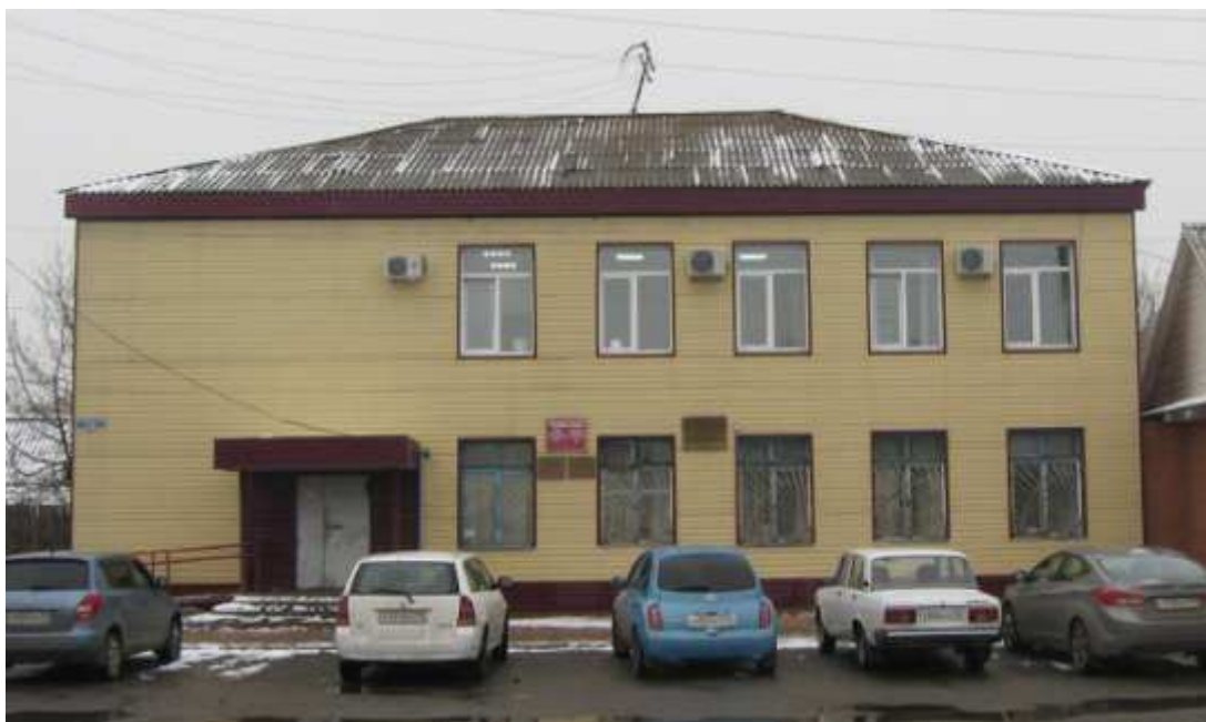
Рисунок 6.1 – Общий вид здания Мировых судей, расположенного по адресу Республика Хакасия, рп Усть-Абакан, ул. Октябрьская, д 32.
