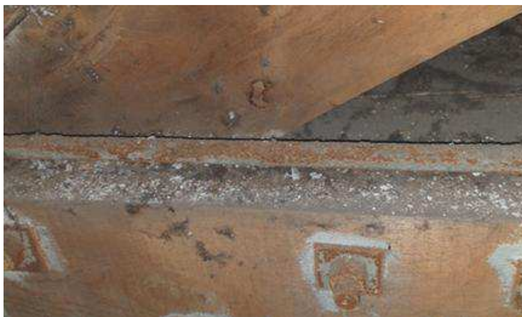
Рисунок 31 - Не докрутили гайку
