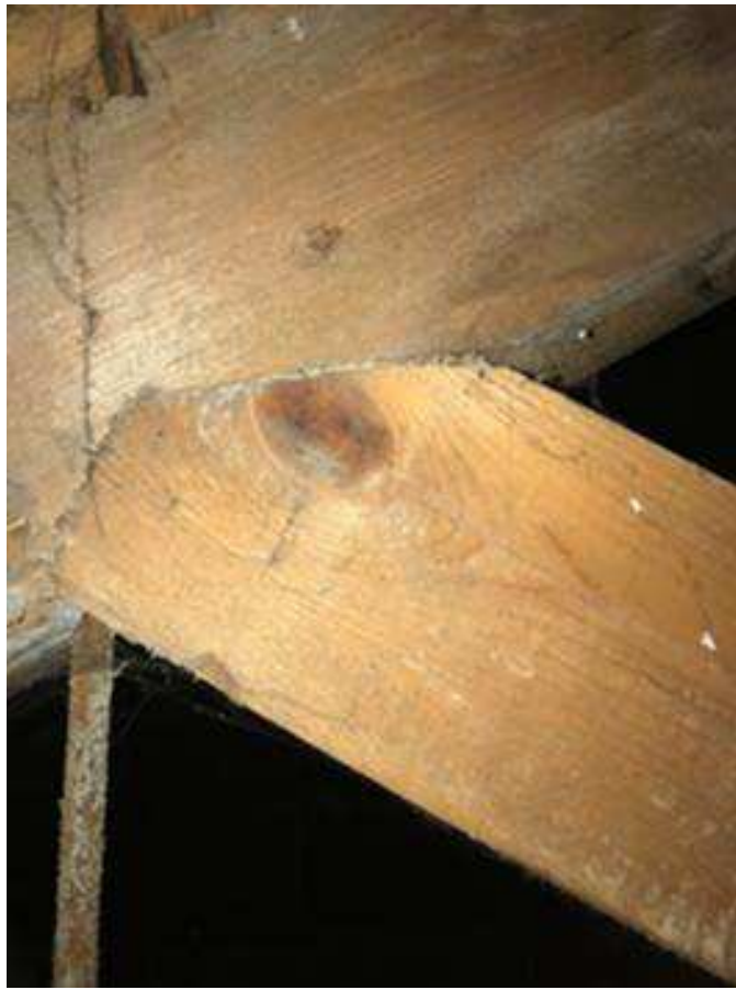
Рисунок 29 - Не плотное прилегания элементов фермы
