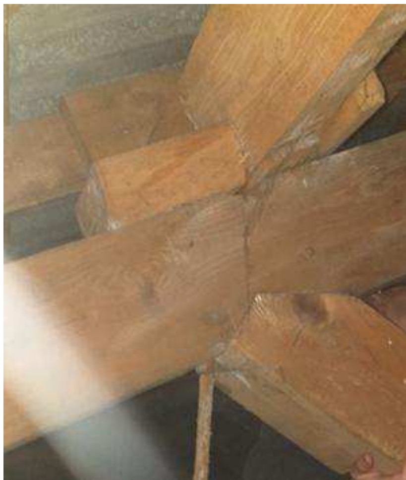
Рисунок 34 - Недостаточное количество крепежных элементов (Прогон опирается на верхний пояс и подпорный брусок держится 2 гвоздями)
