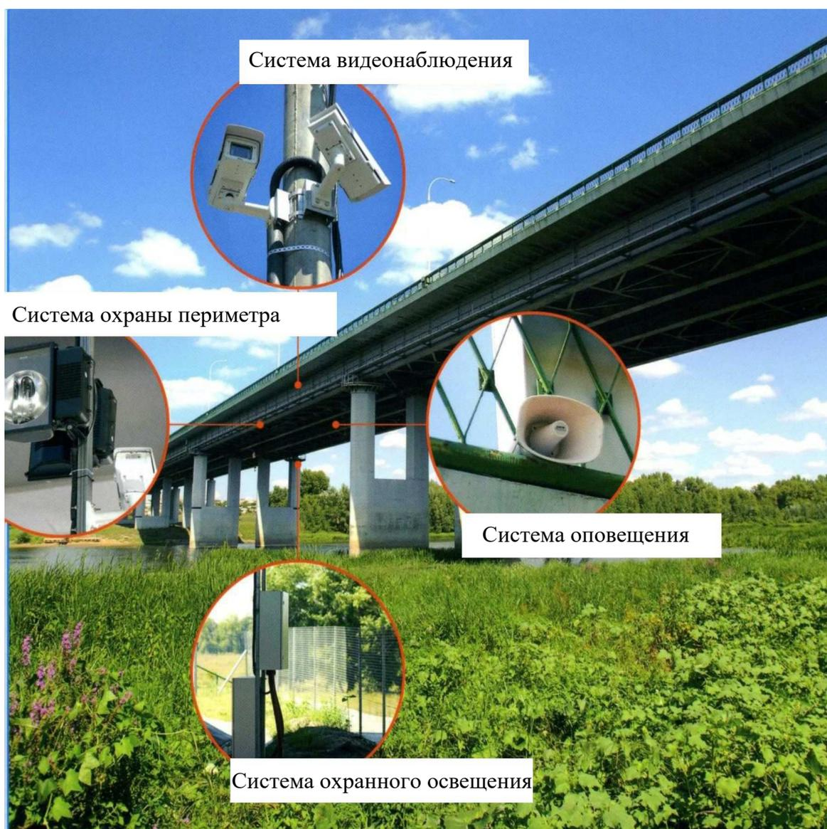
Рисунок 2.1 – Примерный перечень обоснованных технических мер по обеспечению защищенности ОТИ (моста) на магистрали [17]
