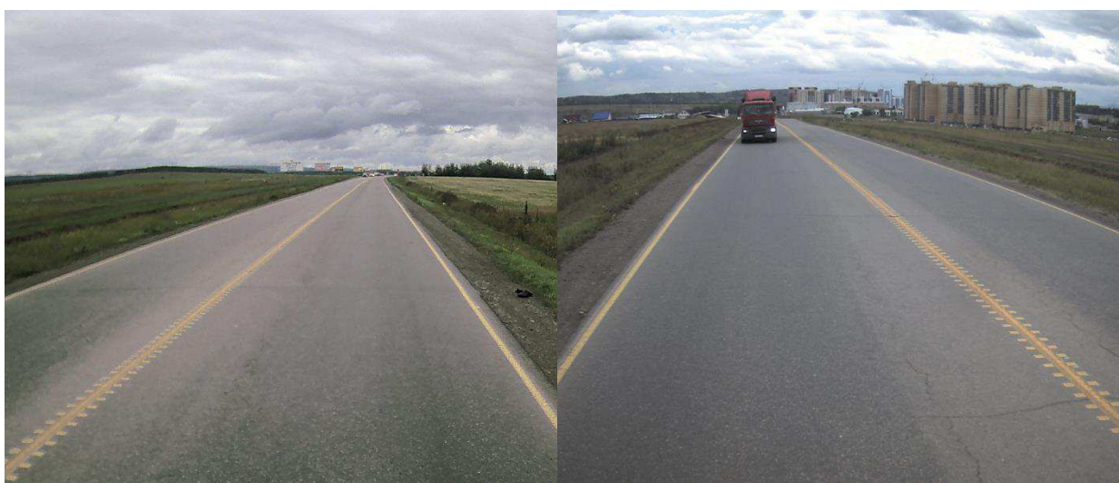
Рисунок 4.3 – Фотографии аварийно-опасного участка автомобильной дороги Красноярск-Элита в прямом и обратном направлении соответственно
