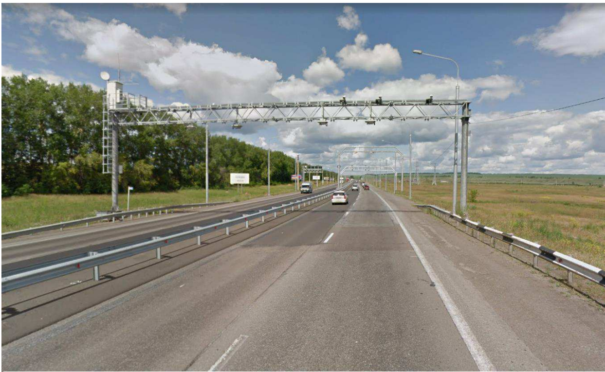
Рисунок 2.2 – Стационарная автоматическая система фотовидеофиксации нарушений ПДД на автомобильной дороге Р 255 «Сибирь»
