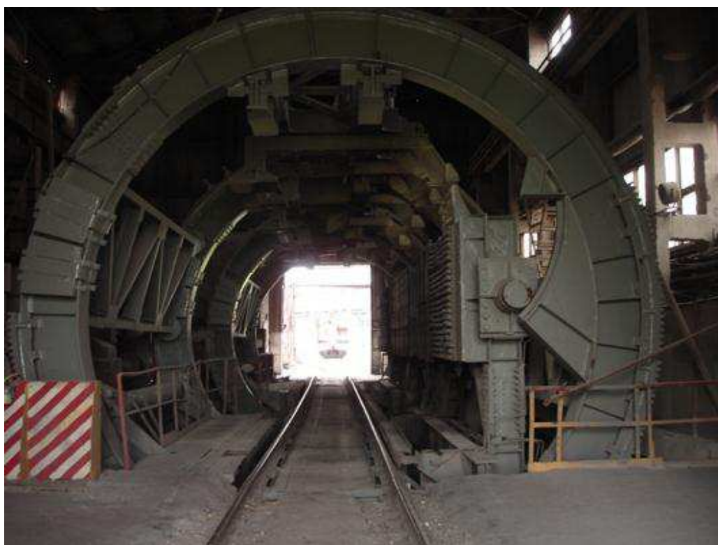
Рисунок 1.2 – Общий вид вагоноопрокидывателя
