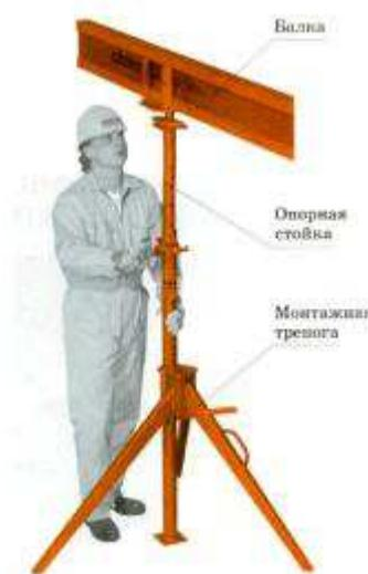
Рисунок 4.4 – Выверка положений стоек по высоте
