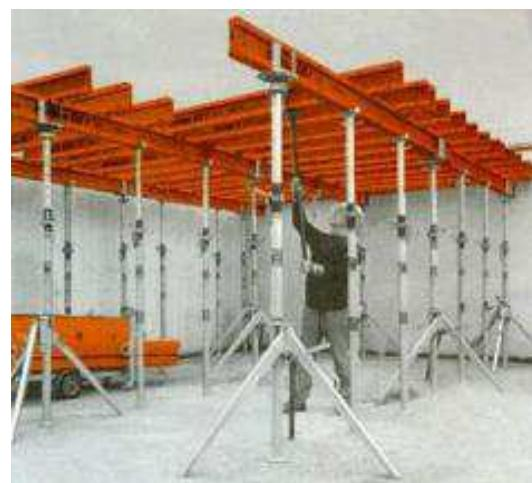
Рисунок 4.3 – Укладка распределительных балок
