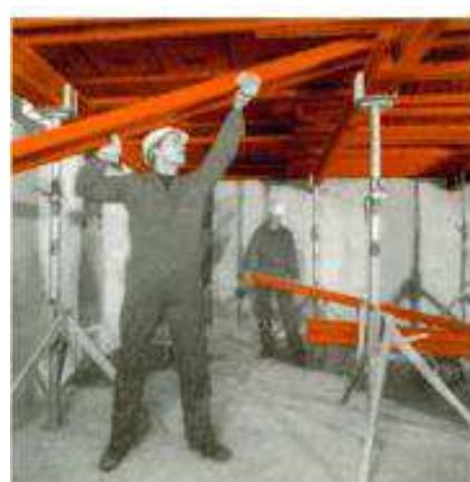
Рисунок 4.6 – Снятие поперечных балок
