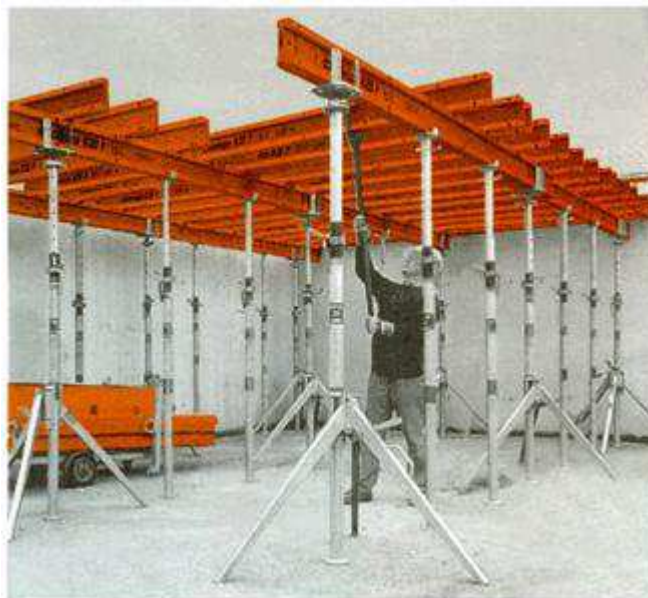
Рисунок 4.4 – Укладка распределительных балок
