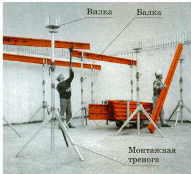
Рисунок 4.3 – Укладка несущих балок
