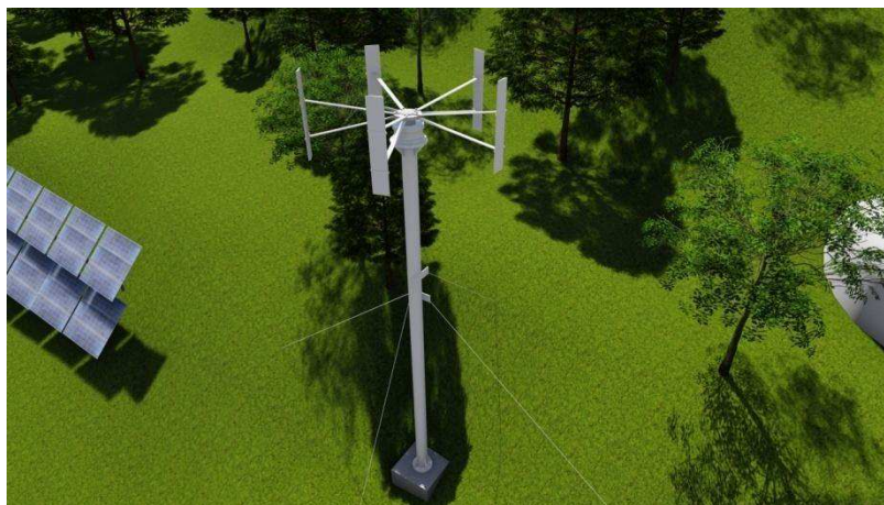
Рисунок 6.1 – Ветроэнергетическая установка с ортогональной ветротурбиной VAWT 1/1,5
