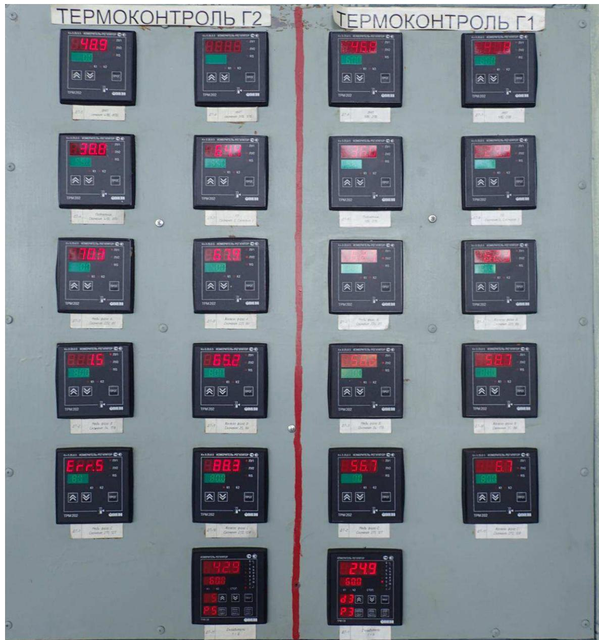
Рисунок 11 – Панель измеритель-регуляторов TPM 202 Овен
