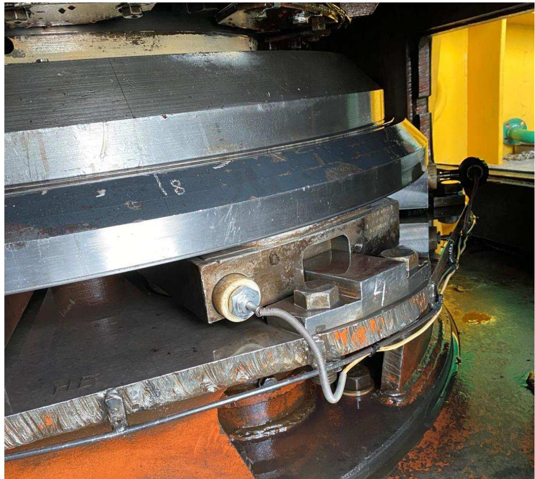
**Рисунок 6 – Расположение ТСП и термобаллона ТКП 160 на сегментах под пятника**
