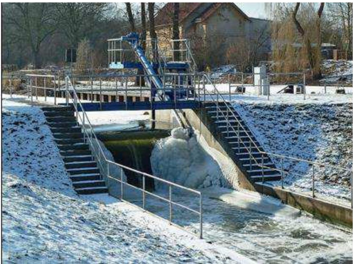
Рисунок 6 - Электроцилиндр на плотине в г. Липе, Германия
