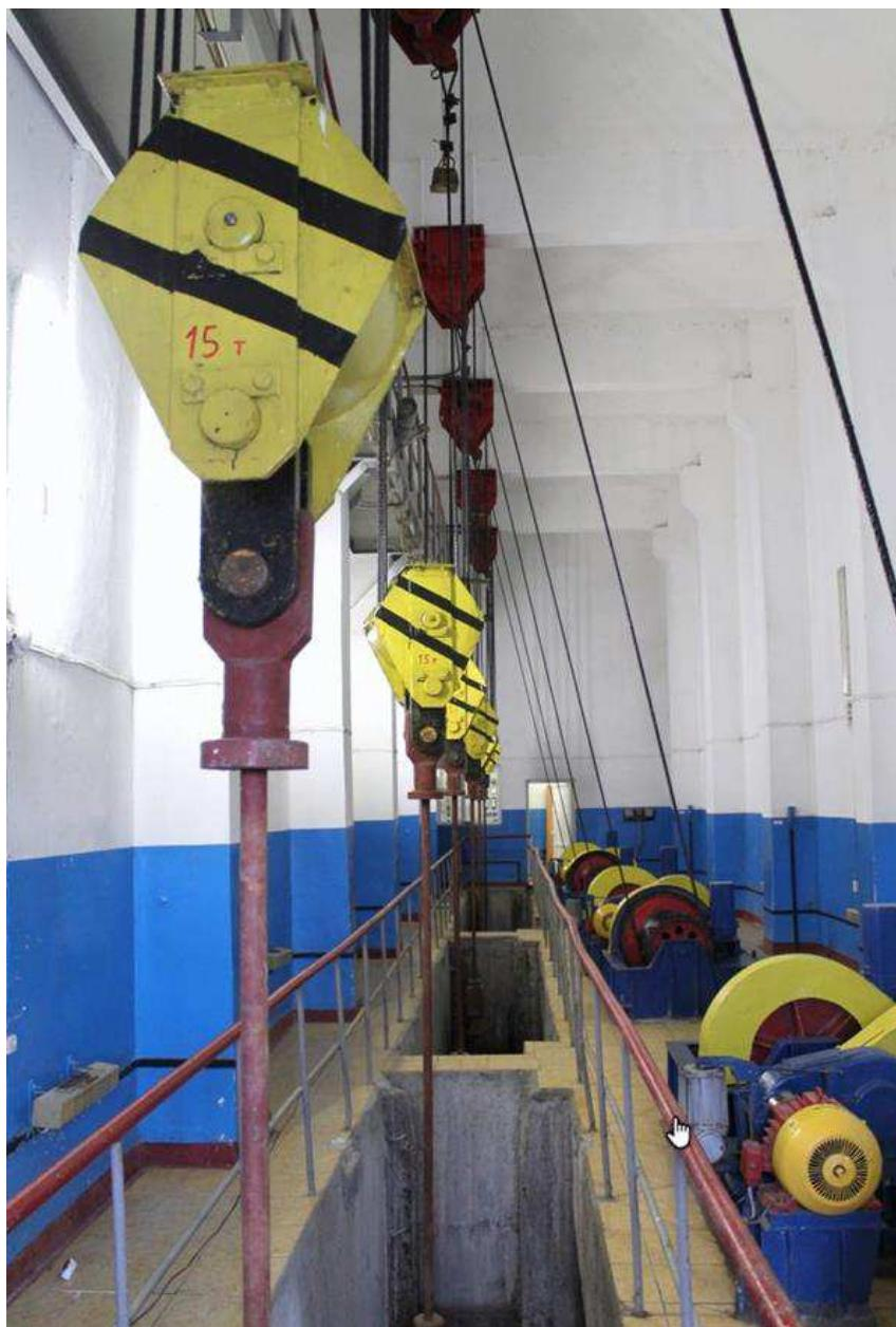
Рисунок 2 – Электрические лебедки, маневрирующие затворами шлюзов – регуляторов ГЭС-3 Кубанского каскада ПАО «РусГидро»
