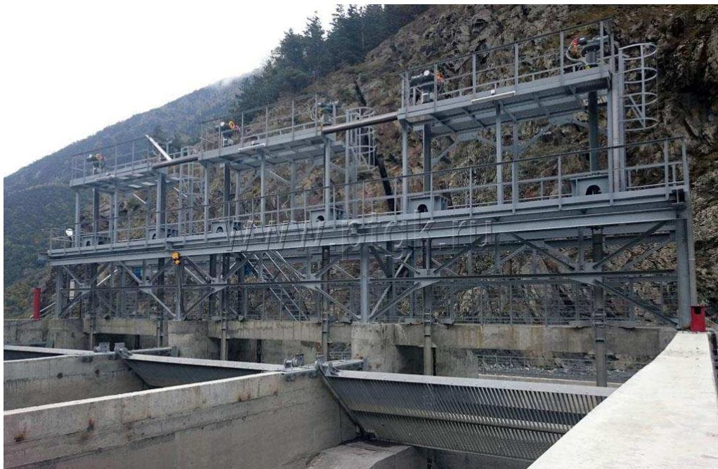
Рисунок 8 – Электромеханические цилиндры, маневрирующие затворы головного узла Эзминской ГЭС
