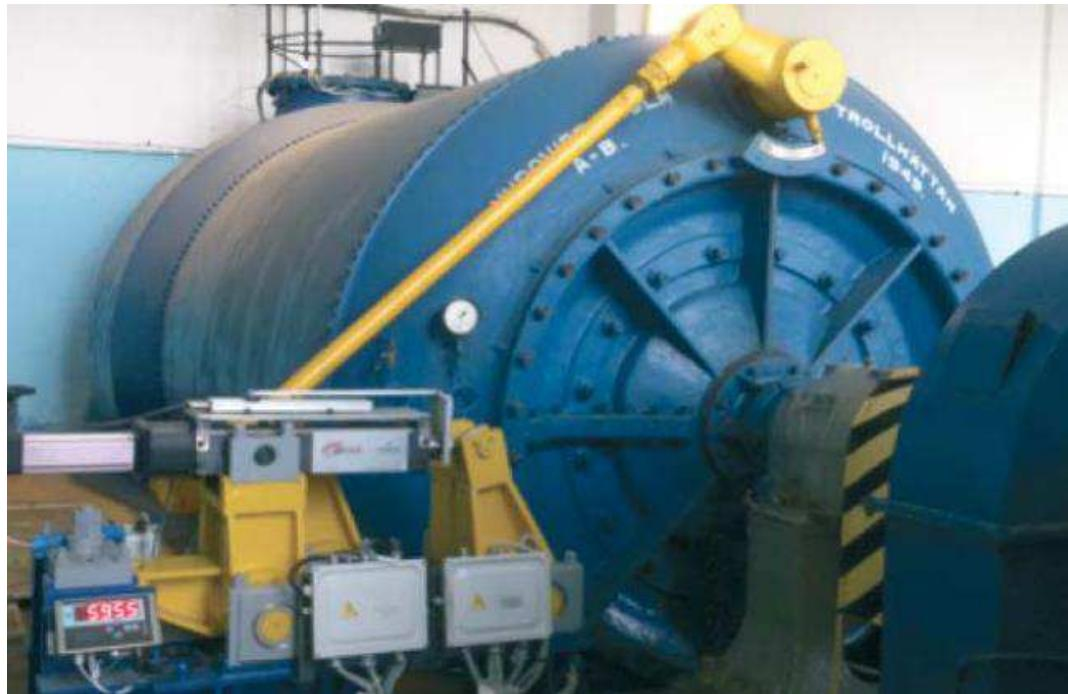
Рисунок 13 – Электроцилиндр, управляющий гидротурбинным оборудованием
