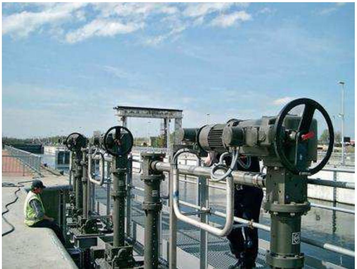
Рисунок 7 - Электроцилиндр на шлюзе кольцевого канала г. Гент, Бельгия
