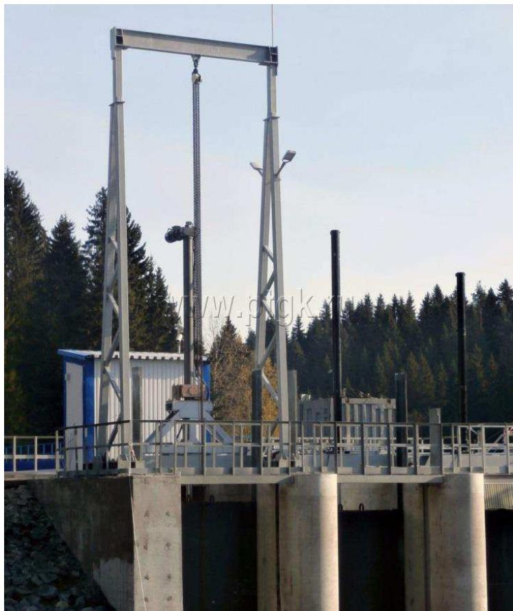
Рисунок 10 – Электроцилиндр с карданным подвесом, маневрирующий плоским затвором, на малой ГЭС Каллиокоски
