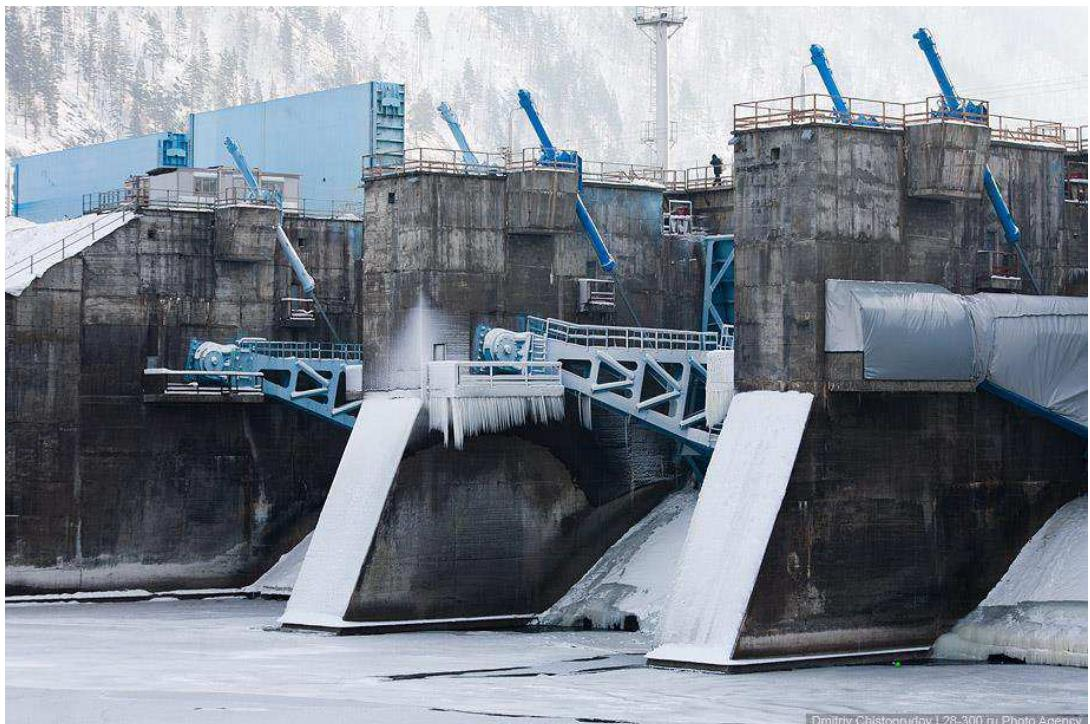
Рисунок 3 – Гидравлические цилиндры, установленные для маневрирования сегментными затворами водосливной плотины Майнской ГЭС
