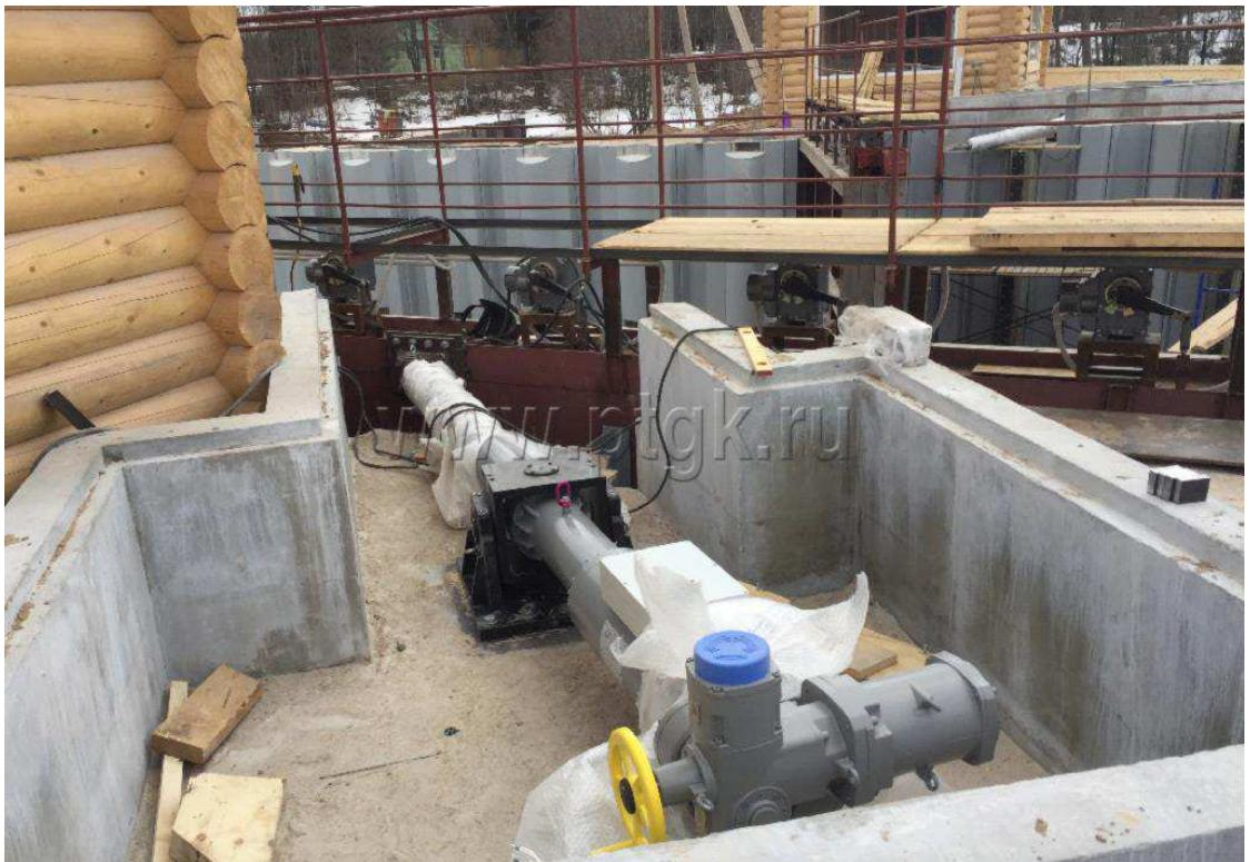
Рисунок 12 – Электроцилиндры, управляющие ворот шлюза №5 Северо-Двинской шлюзованной системы
