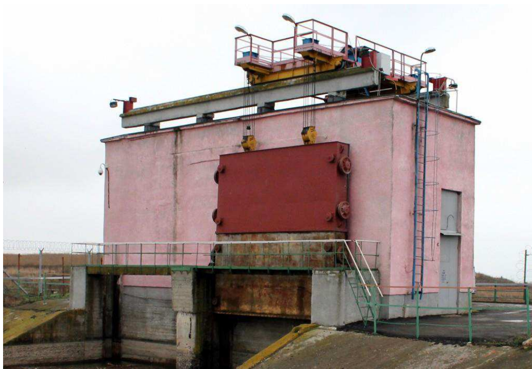
Рисунок 8.1 - Плоский затвор
