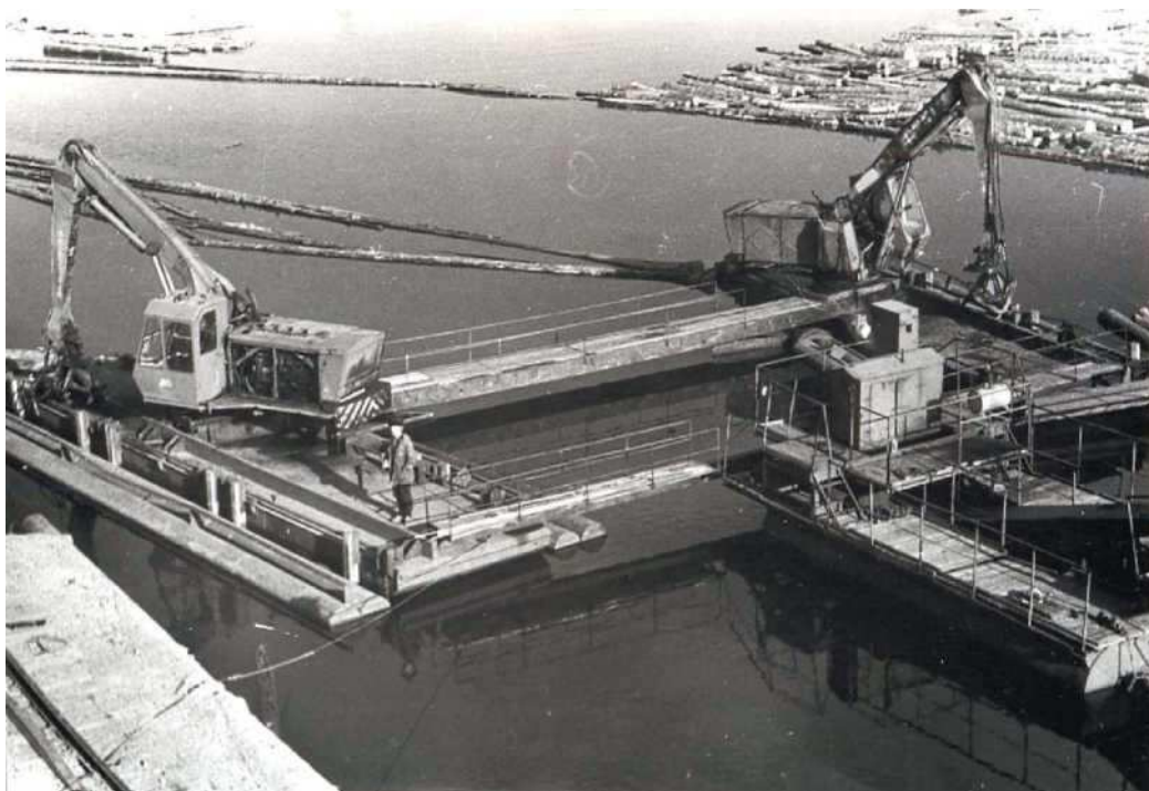
Рисунок 9.2 – очистка акватории на Братской ГЭС
