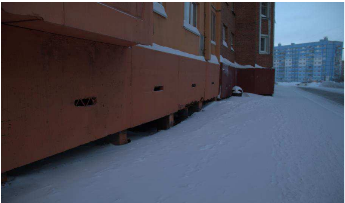
Рисунок 1.2 – Конструкция вентилируемого подполья
