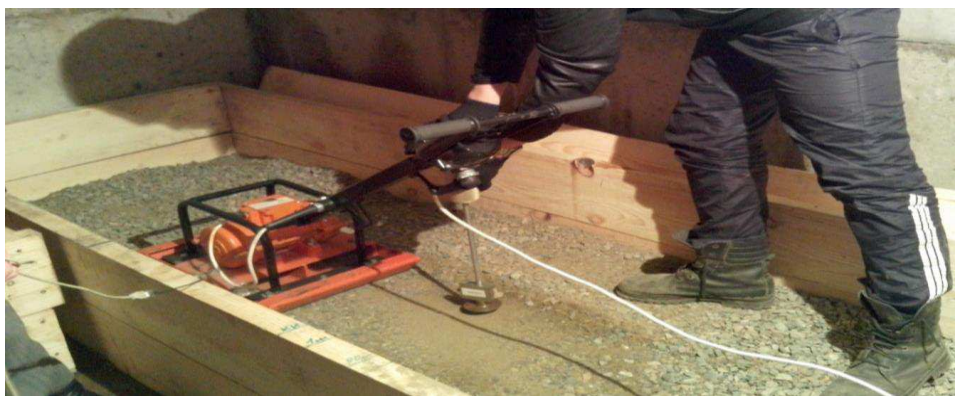
Рисунок 37 – Проверка плотности грунта с помощью плотномера ДПУ
