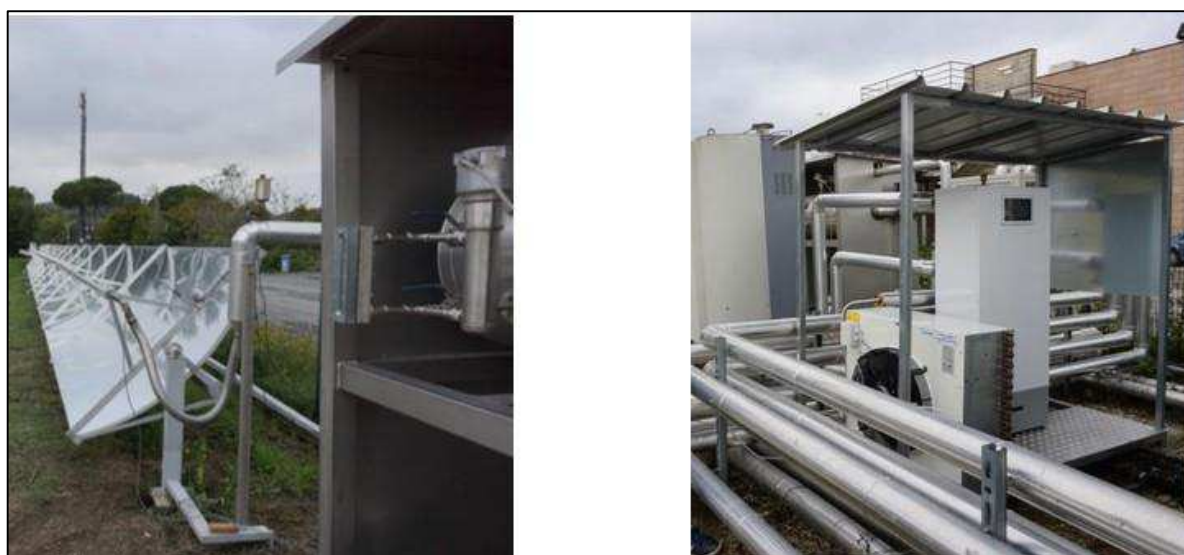
Рисунок 1.22 – Установка, слева – коллекторы, справа – прототип ОРЦ и сухой кулер
