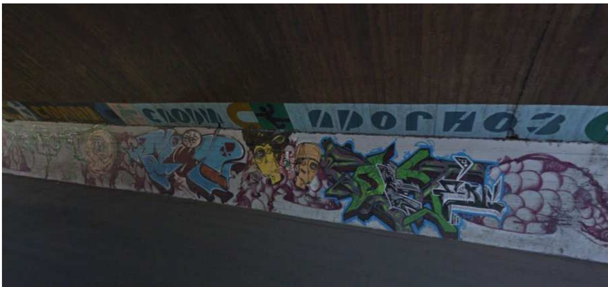
Приложение В.3 (20) – граффити под Коммунальным мостом до ремонта
