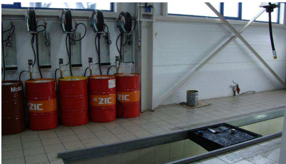
Рисунок 1.4 – Пост замены эксплуатационных жидкостей
