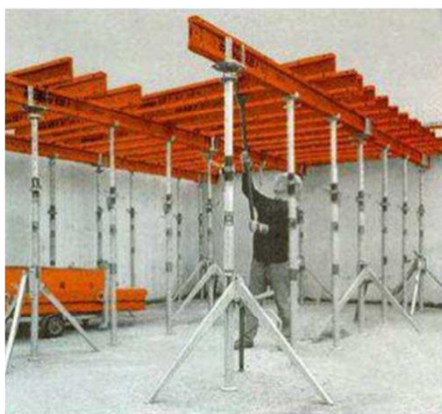
Рисунок 4.2 – Установка главных и второстепенных балок
