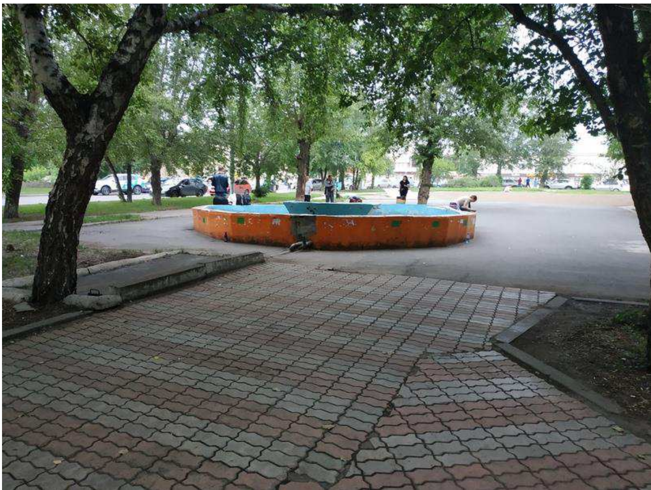
Рисунок 27 – Неработающий существующий фонтан
