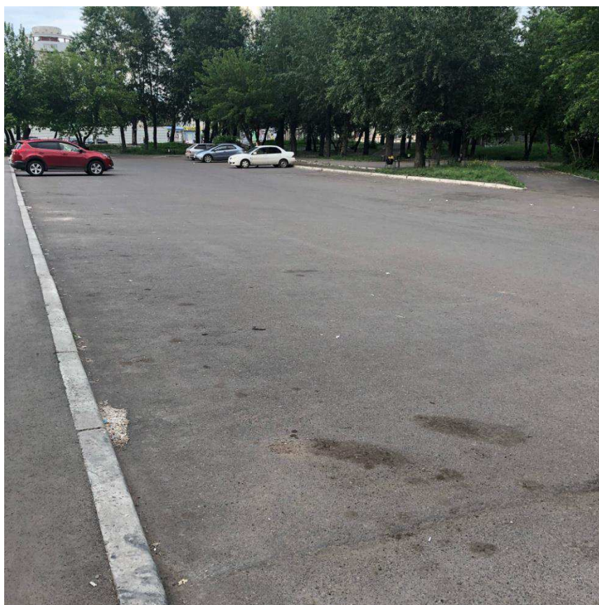
Рисунок 10– Отсутствие разметки на парковке
