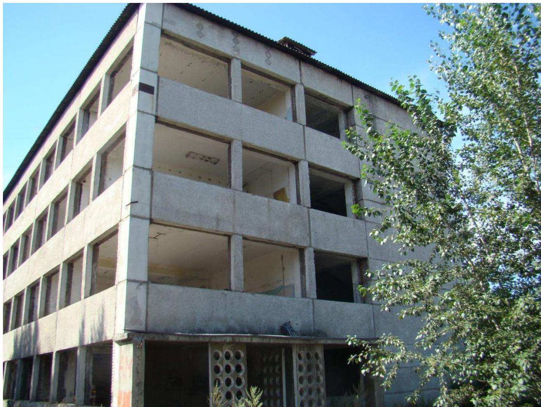
Рисунок 3 – Боковой фасад здания в осях А-Г. Общий вид.
