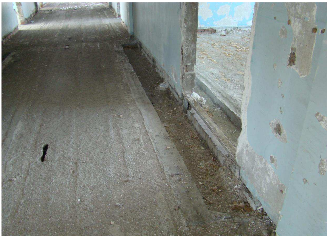
Рисунок 9 – Продольная железобетонная диафрагма жесткости по оси Б в осях 3-4. Характерный вид. Крупный план.
