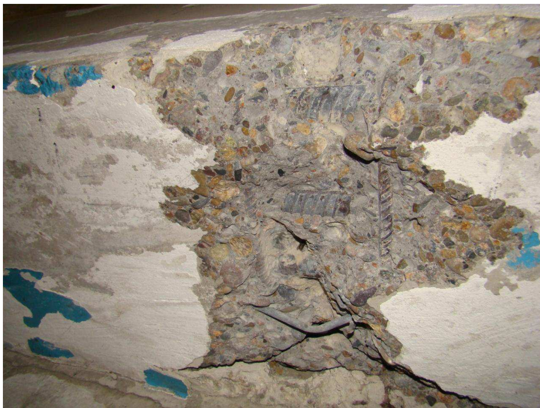
Рисунок 26 – Армирование растянутой зоны ригеля. Крупный план.
