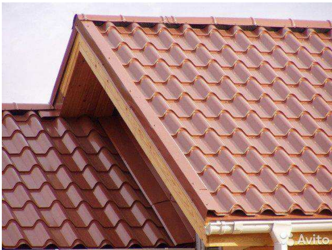
Рисунок 41 – Фрагмент крыши с металлочерепичной кровлей
