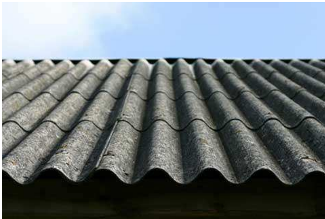
Рисунок 39 – Фрагмент крыши, покрытой асбестоцементным шифером
