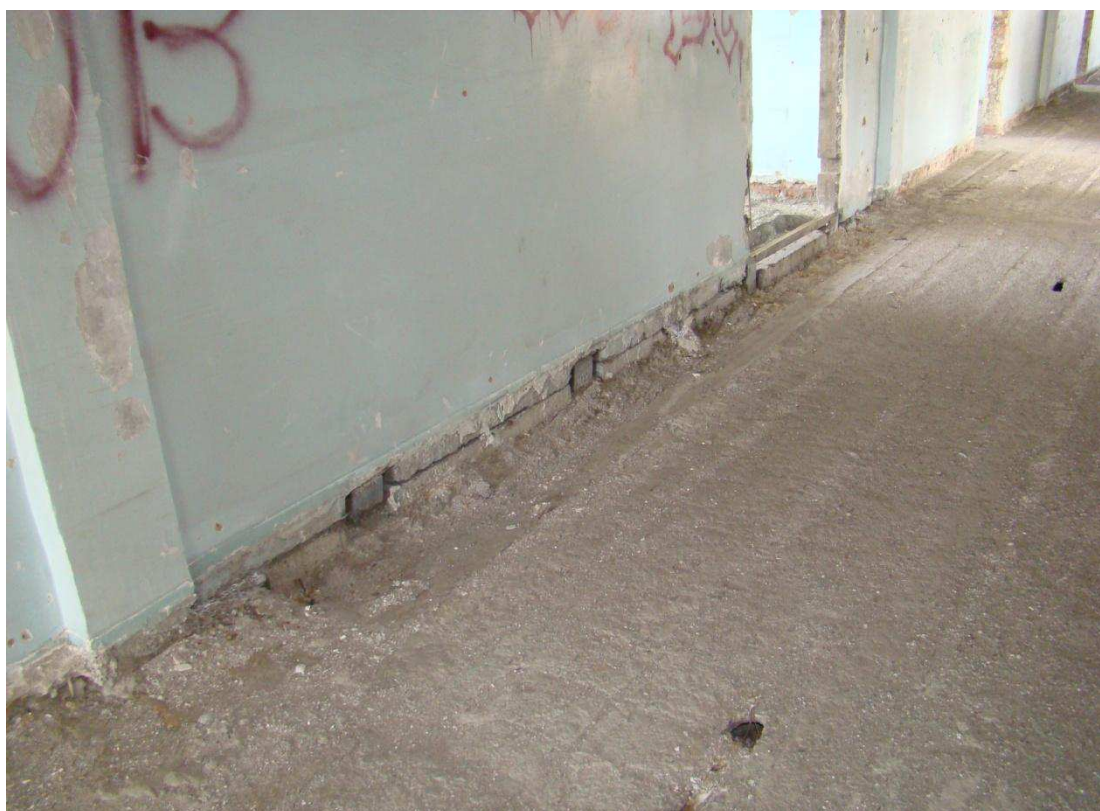
Рисунок 10 – Соединение диафрагм жесткости между этажами стальными закладными деталями. Характерный фрагмент.
