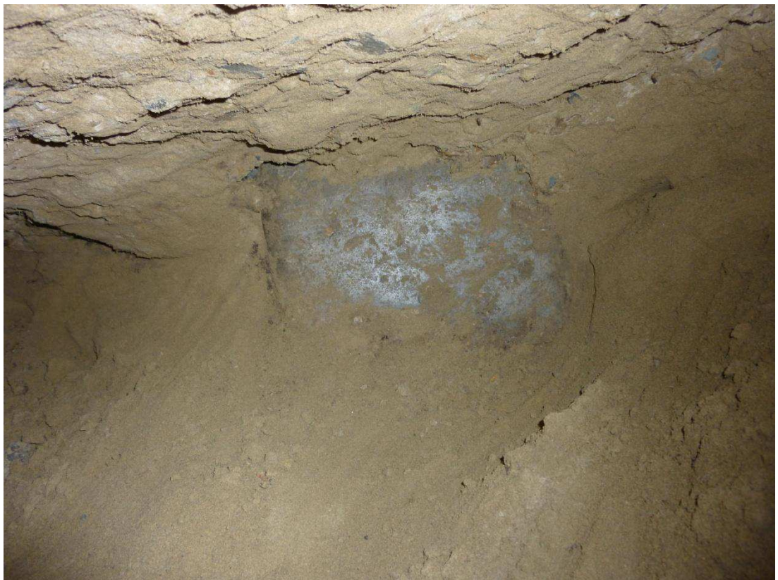
Рисунок 20 – Железобетонная свая в фундаменте здания.
