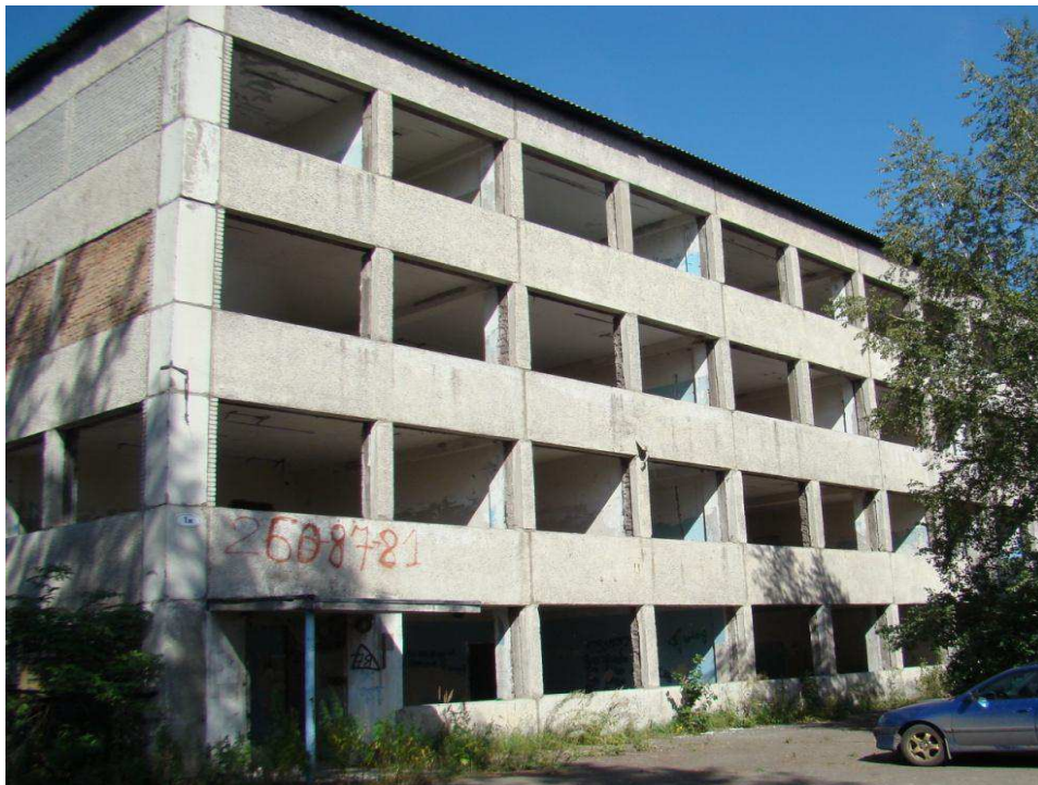
Рисунок 1 – Главный фасад здания в осях 1-7. Общий вид.
