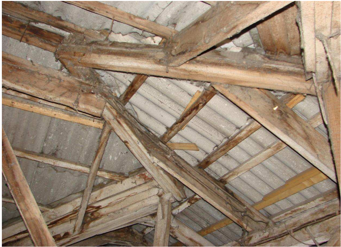
Рисунок 17 – Стропильная система вальмовой четырехскатной крыши здания. Характерный фрагмент. Крупный план.
