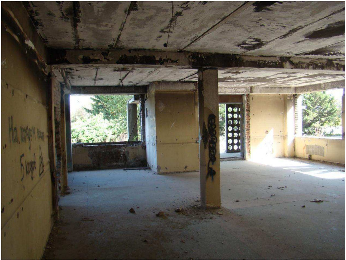
Рисунок 5 – Характерное помещение на первом этаже в осях 5-7, А-В.
