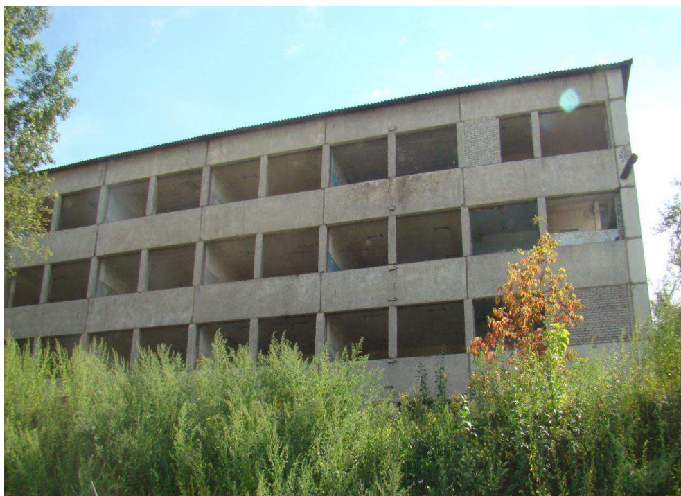
Рисунок 2 – Задний фасад здания в осях 7-1. Общий вид.
