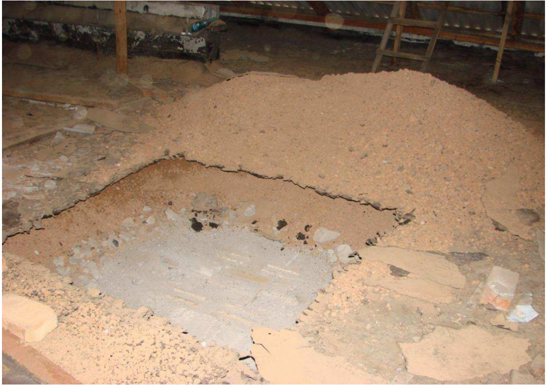
Рисунок 30 – Вскрытие утеплителя на крыше здания. Утеплитель – керамзитовый гравий толщиной 150-200 мм.
