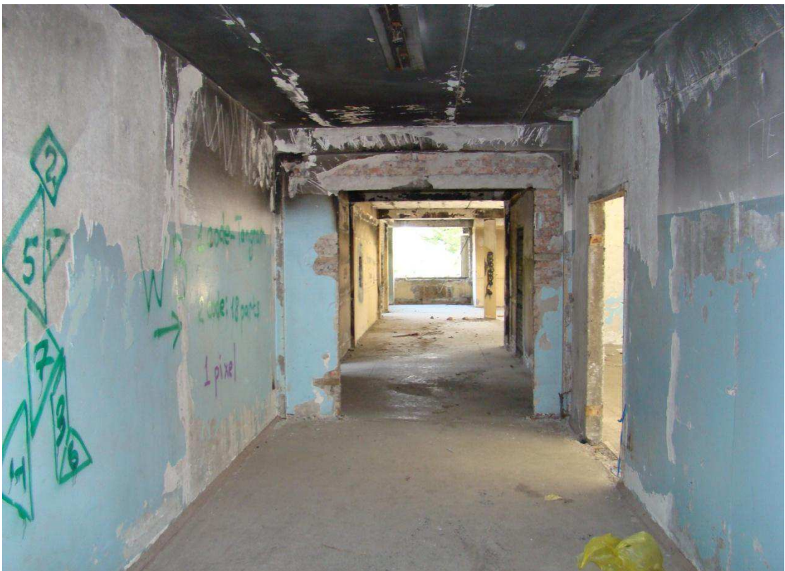
Рисунок 6 – Коридор на первом этаже здания в осях Б-В. Общий вид.
