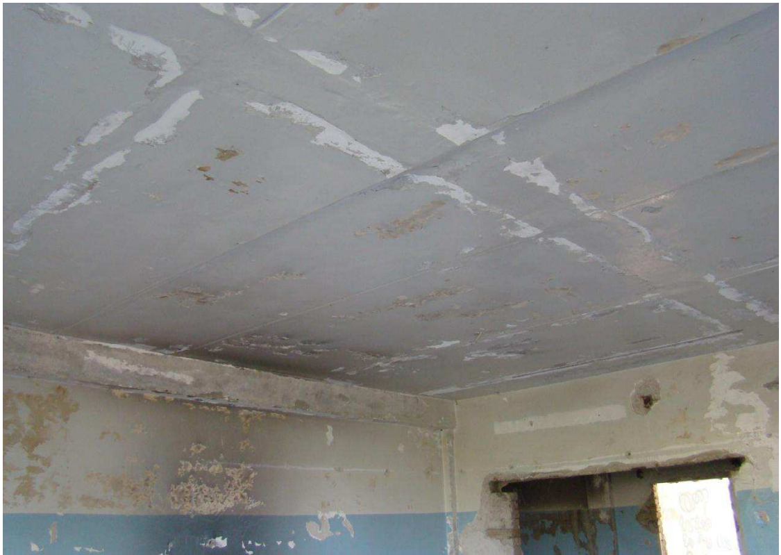
Рисунок 7 – Несущие конструкции перекрытия: ригель и плиты перекрытия. Характерный фрагмент. Крупный план.
