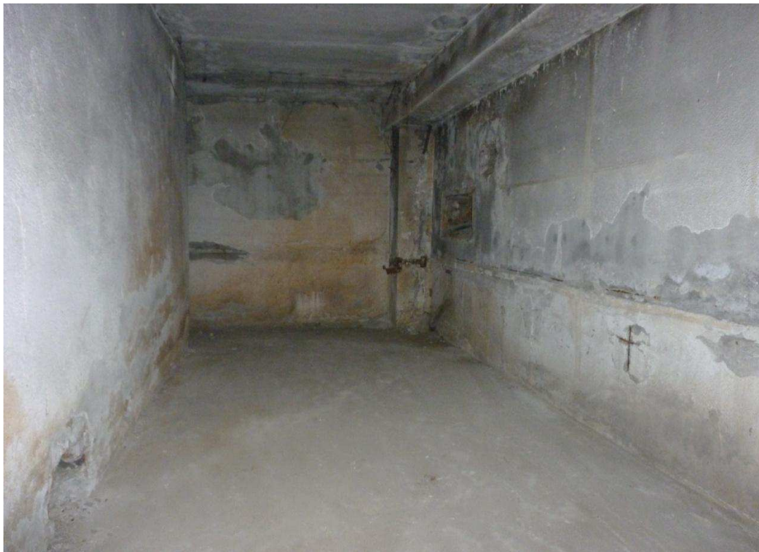
Рисунок 18 – Внутренне помещение подвала в осях 1-2, А-Б.
