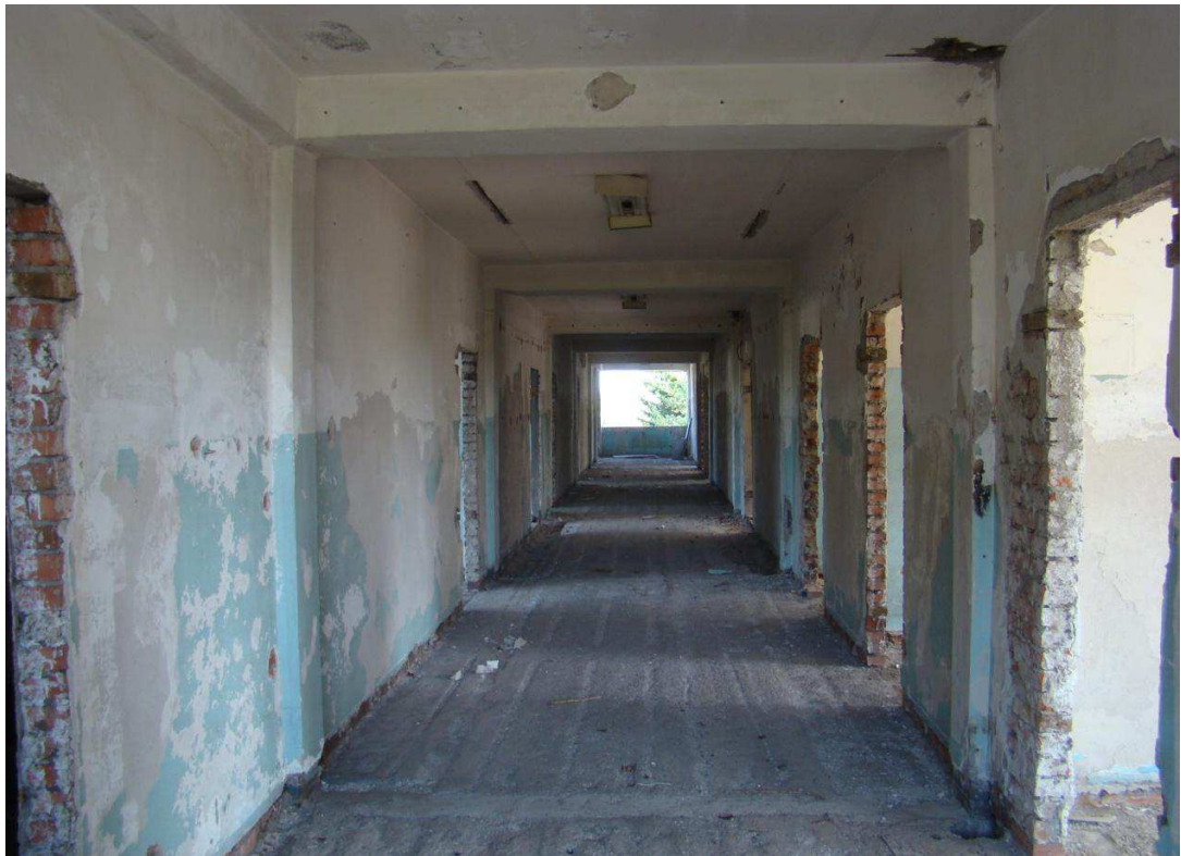
Рисунок 15 – Коридор в осях Б-В на третьем этаже здания. Несущие конструкции. Кирпичные перегородки.
