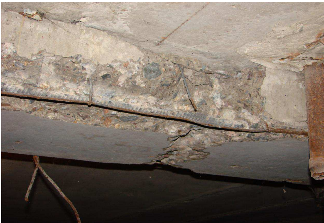
Рисунок 28 – Вскрытие ригеля в подвальной части здания по оси б между осями А-Б для определения ее армирования. Крупный план.
