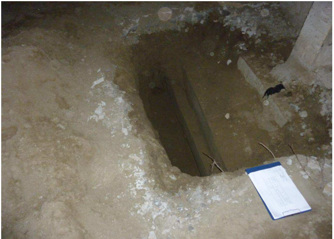
Рисунок 19 – Отрытый шурф в подвале здания на пересечении осей 3 и А. Железобетонный монолитный ростверк. Крупный план.
