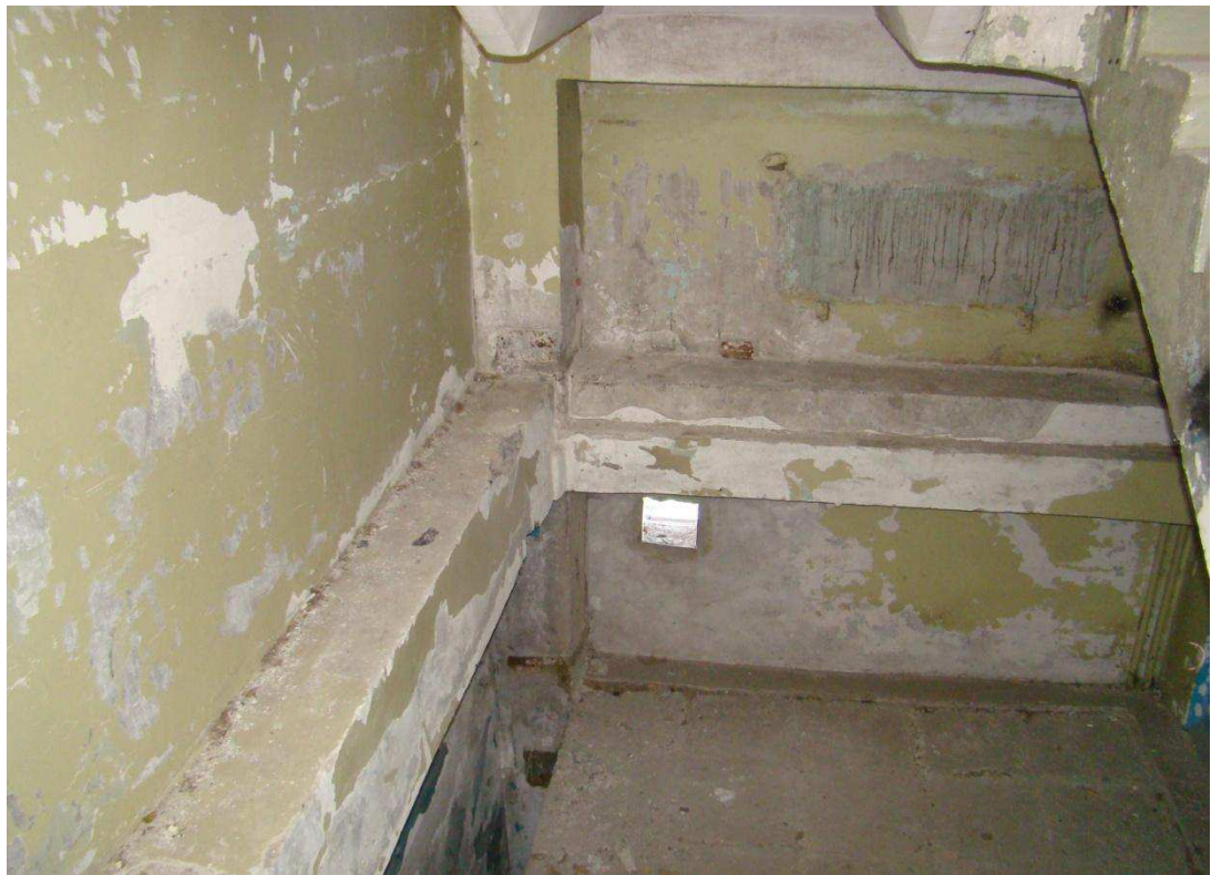
Рисунок 12 – Обвязка лестничного марша в осях 1-2, В-Г. Характерный вид. Крупный план.
