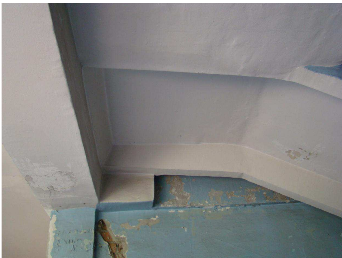
Рисунок 14 – Характерный фрагмент лестницы в осях 6-7, В-Г.
