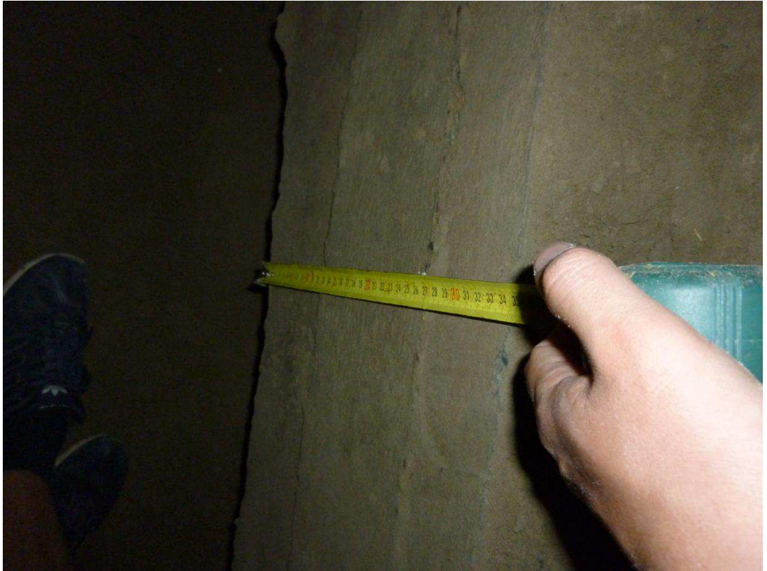
Рисунок 21 – Измерение размеров железобетонного ростверка.
