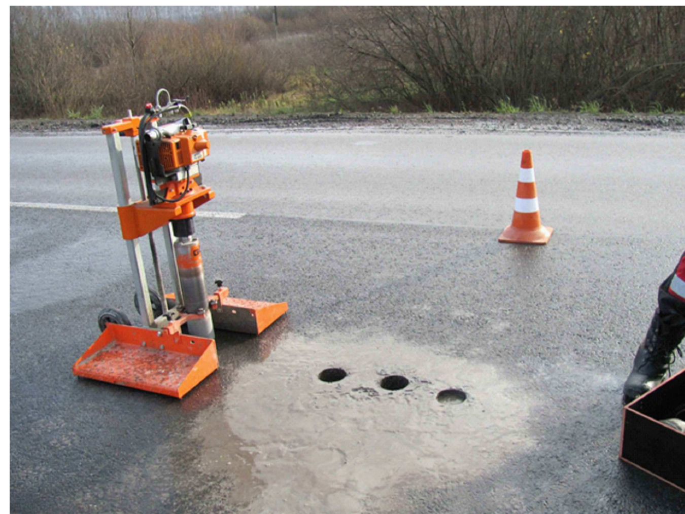
Рисунок 2 - Отбор проб асфальтобетона
