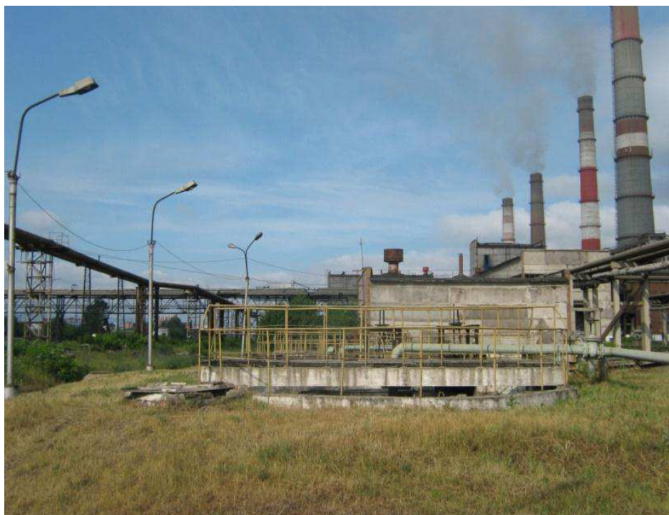
Рисунок 8 - Площадка сооружений насосной станции промливневых вод (НПВ)
