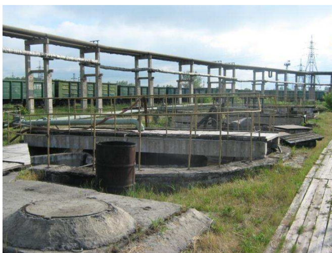
Рисунок 7 - Песколовки горизонтальные
