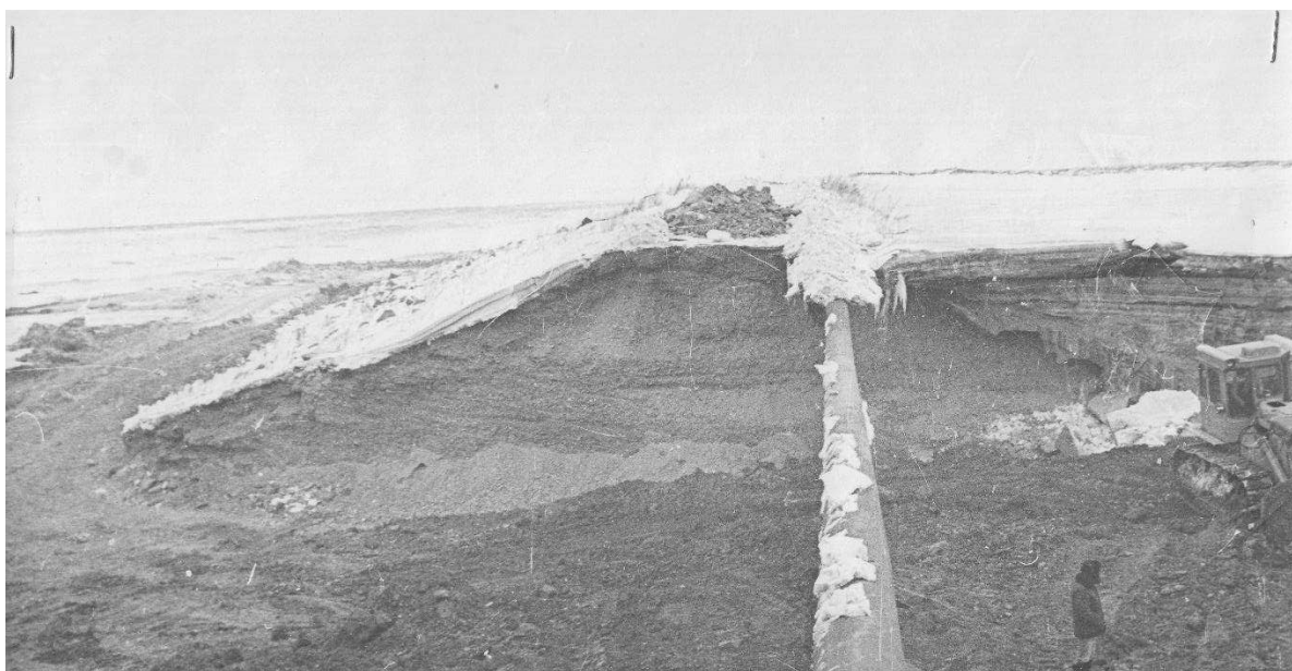
Рисунок 11 – Разрушения дамбы на золоотвале Абаканской ТЭЦ
