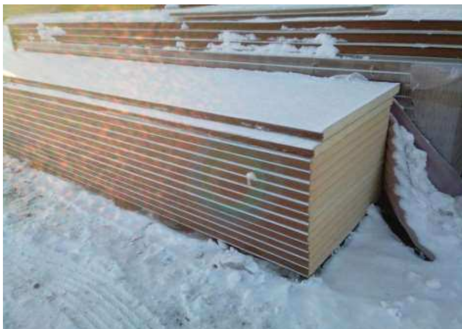
Рисунок 22- Нарушение складирования сэндвич-панелей при атмосферных осадках (снег)
