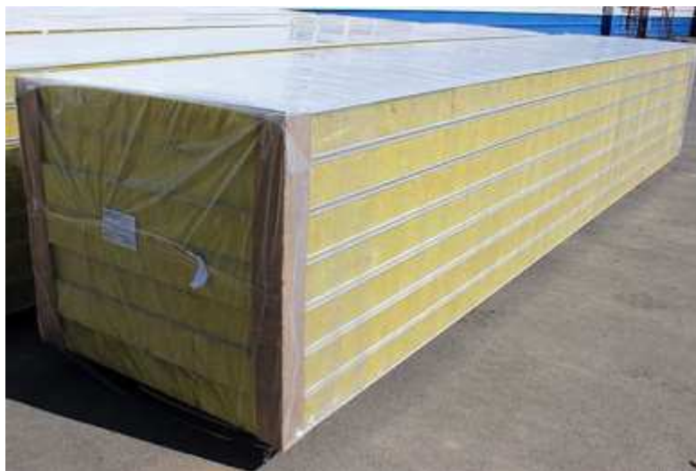
Рисунок 23 - Правильное складирование панелей на строительной площадке
