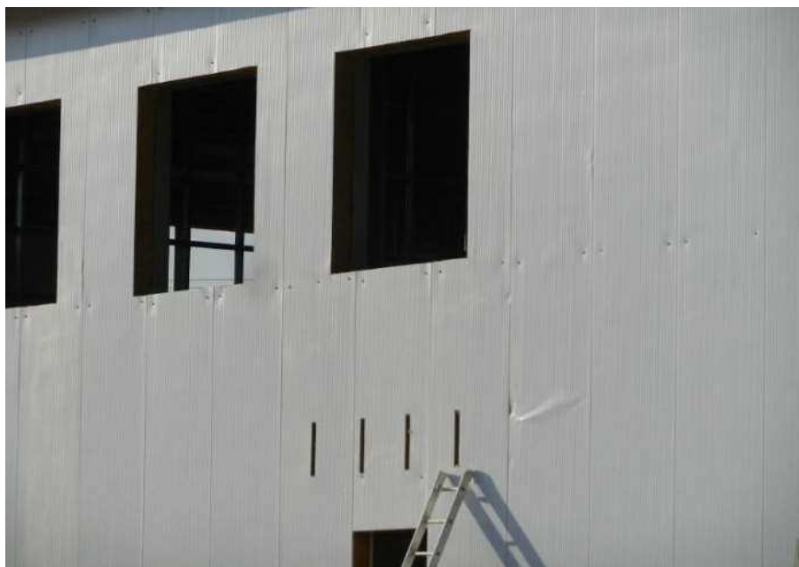
Рисунок 19- Смятие сэндвич-панелей из-за перетянутых саморезов
