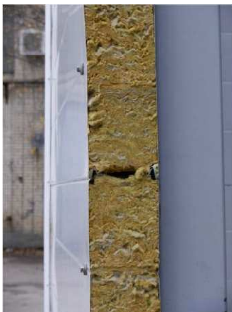
Рисунок 25- Утеплитель сомнительного качества
