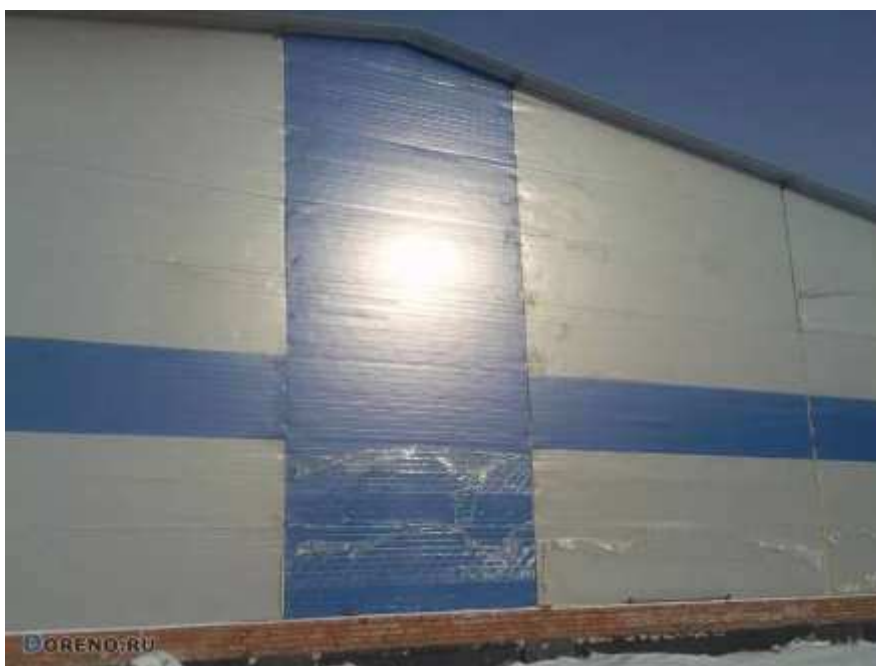
Рисунок 20- Смятие сэндвич-панелей на опорах из-за перетянутых саморезов
