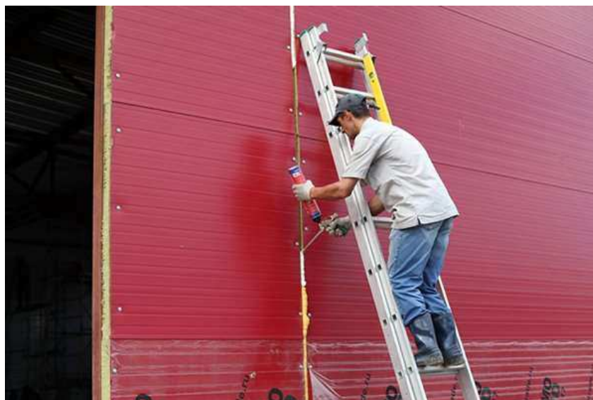
Рисунок 14- Уплотнение монтажной пеной стыков сэндвич-панелей
